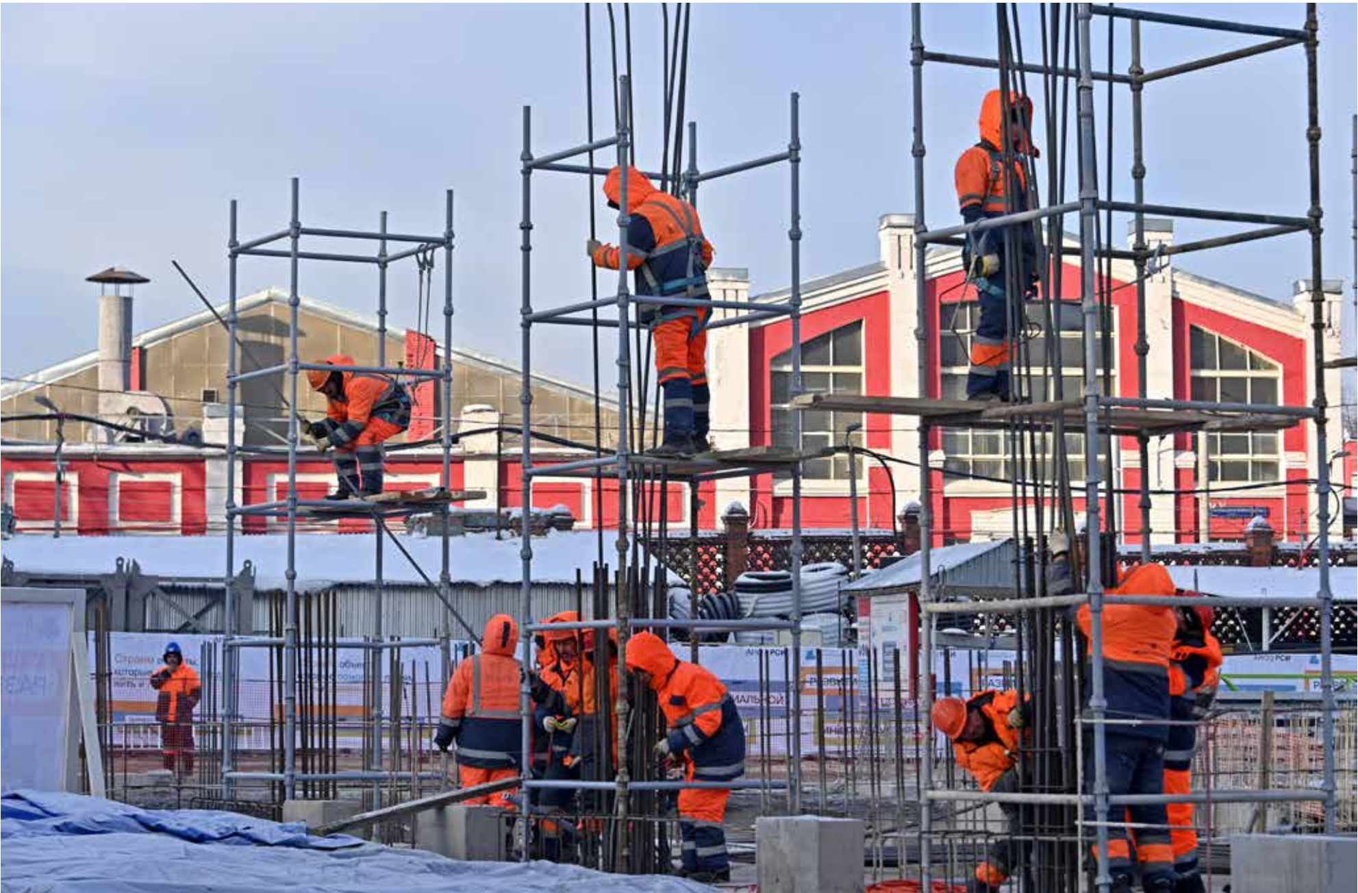
Строительство нового корпуса детской больницы св. Владимира в районе Сокольники
