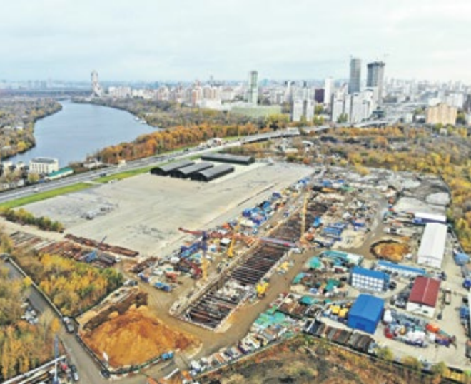
Площадка строительства станции «Карамышевская» Большой кольцевой линии
