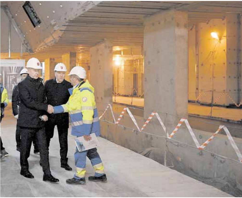
Сергей Собянин (крайний слева) и Андрей Бочкарёв осматрели ход строительства станции БКЛ «Печатники»
