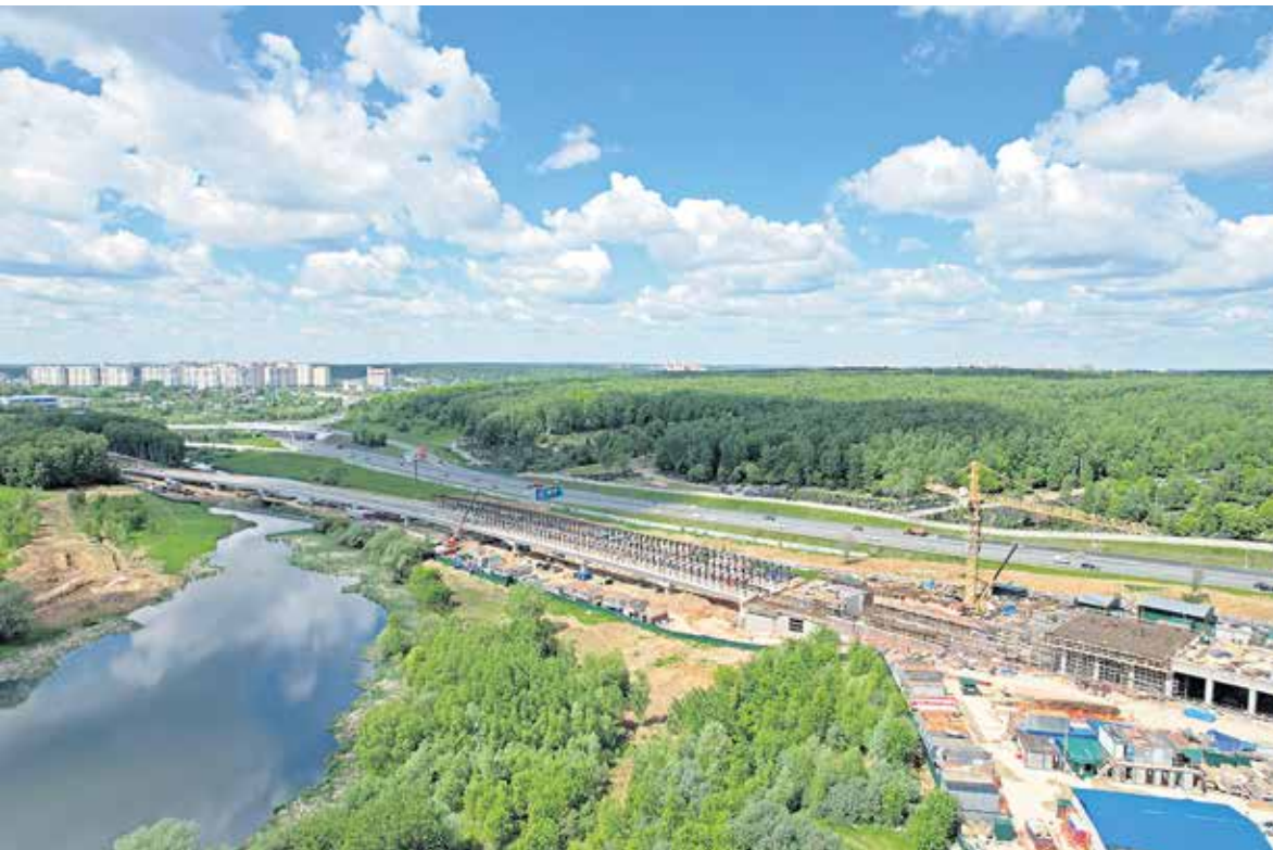
Метромост через реку Ликову у станции метро «Пыхтино»
