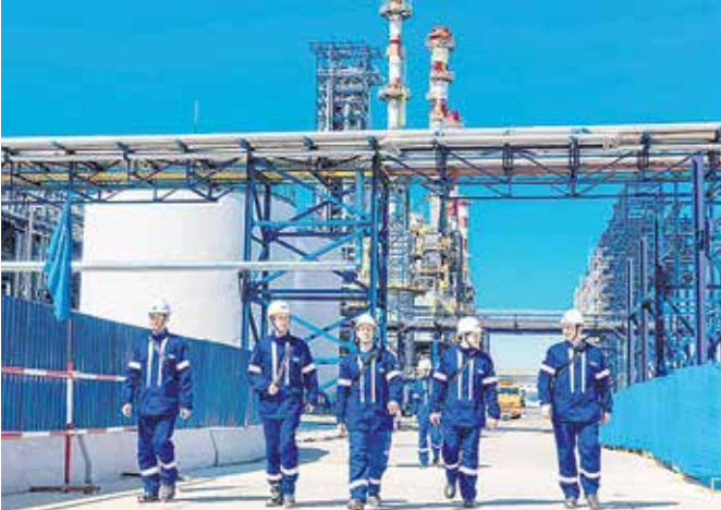
На Московском НПЗ приступили к заключительному этапу реконструкции
