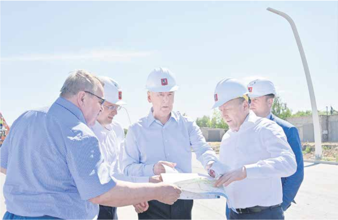
Мэр Москвы Сергей Собянин в ходе осмотра строящегося участка МСД
