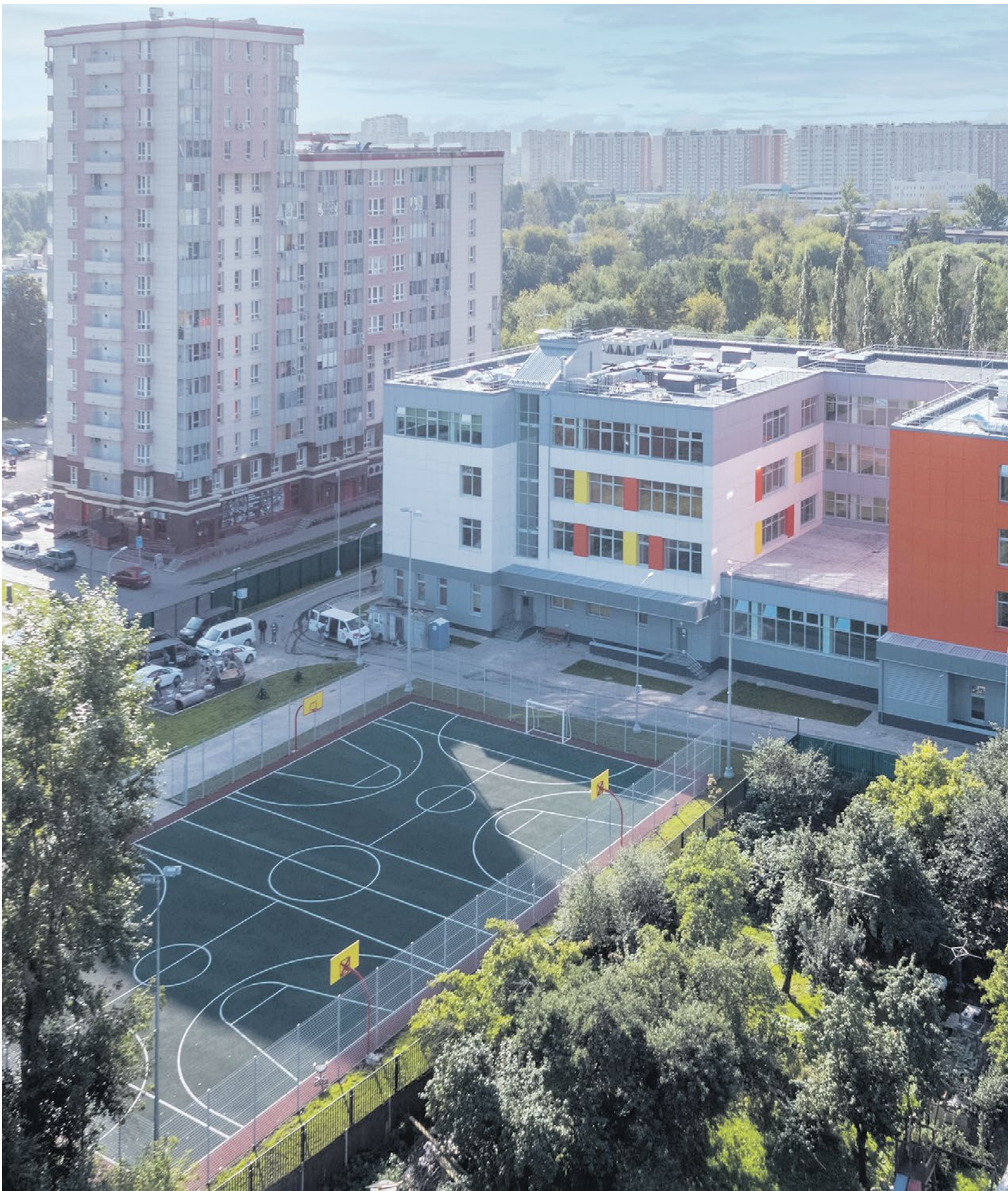
Здание школы № 2117 в Щербинке
