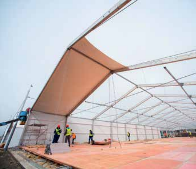
Строительство временных корпусов завершится 7 мая
