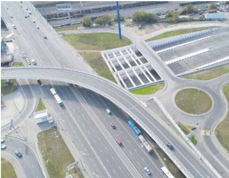
Строительство участка Северо-Восточной хорды от железнодорожных путей Ярославского направления до улицы Лосиноостровской
