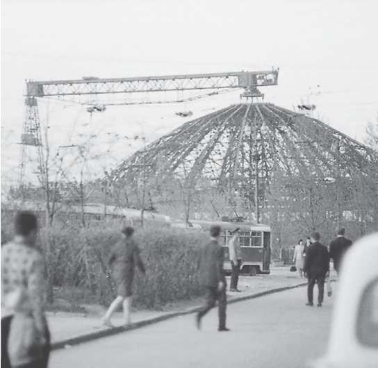
Строительство Цирка на проспекте Вернадского
