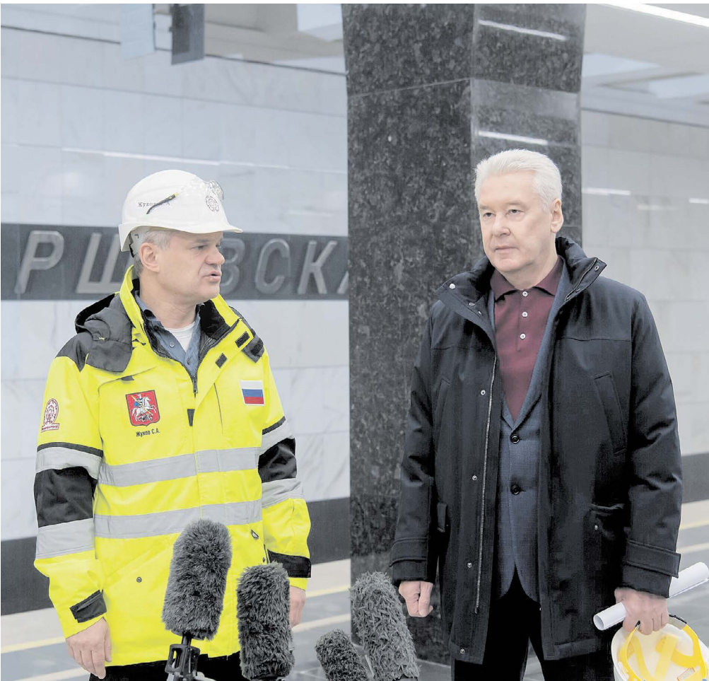
Мэр Москвы Сергей Собянин осматривает работы по реконструкции станции «Варшавская» (БКЛ) метро
