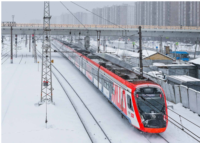
Путепровод через пути МЦД-1 рядом со станцией Бескудниково
