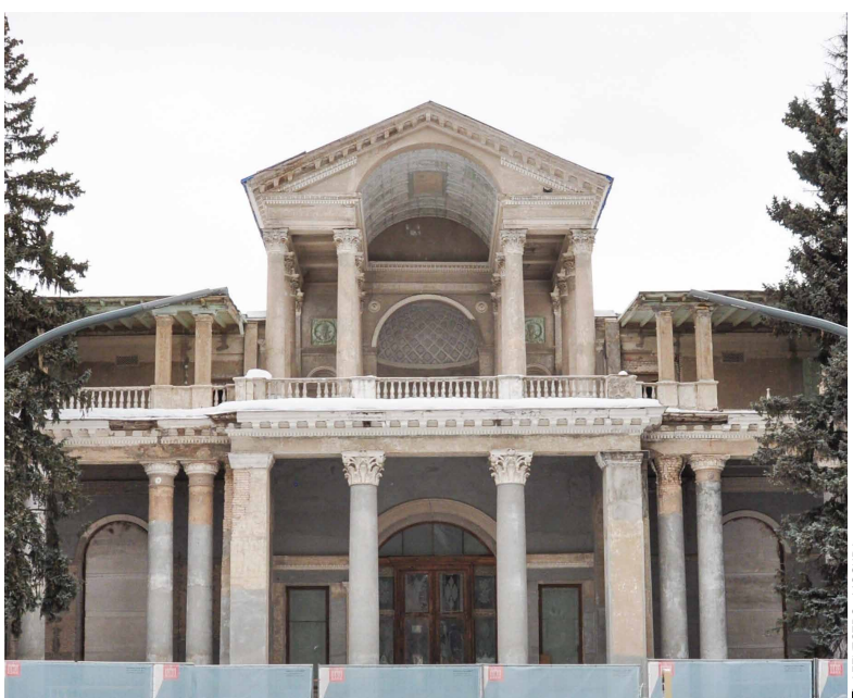
Реставрация здания ресторана «Золотой колос» на ВДНХ
