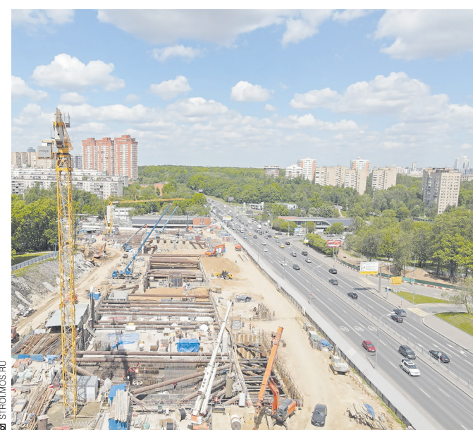
Строительство станции БКЛ «Кунцевская»
