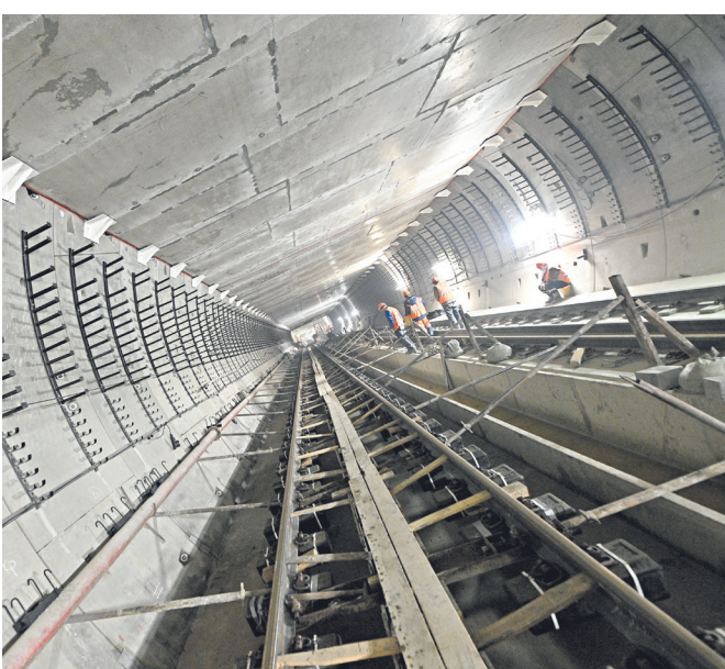
Строительство станции БКЛ «Терехово»
