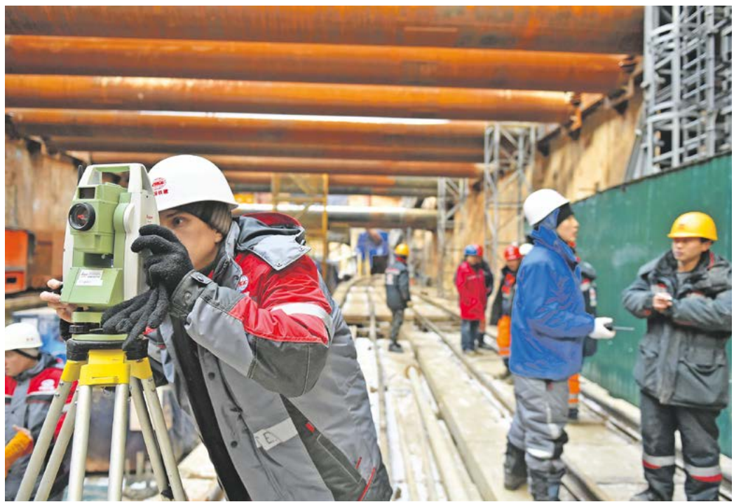
Площадка строительства станции метро «Проект Вернадского» БКЛ
