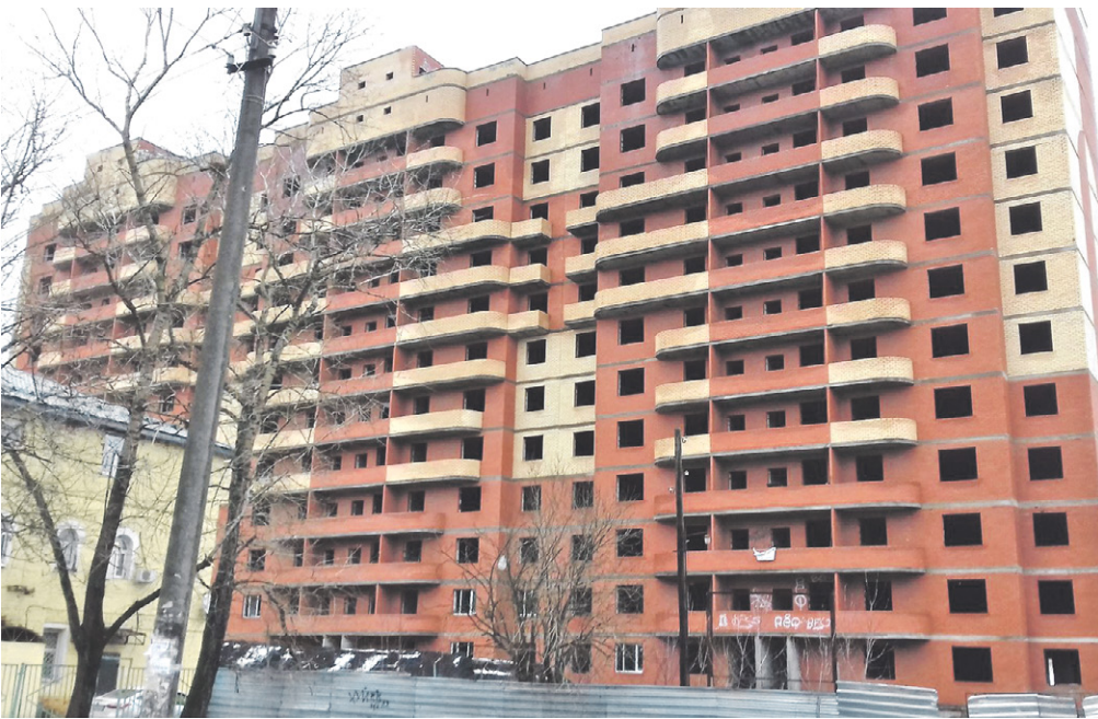
Недостроенный жилой дом в поселении Кокошкино
