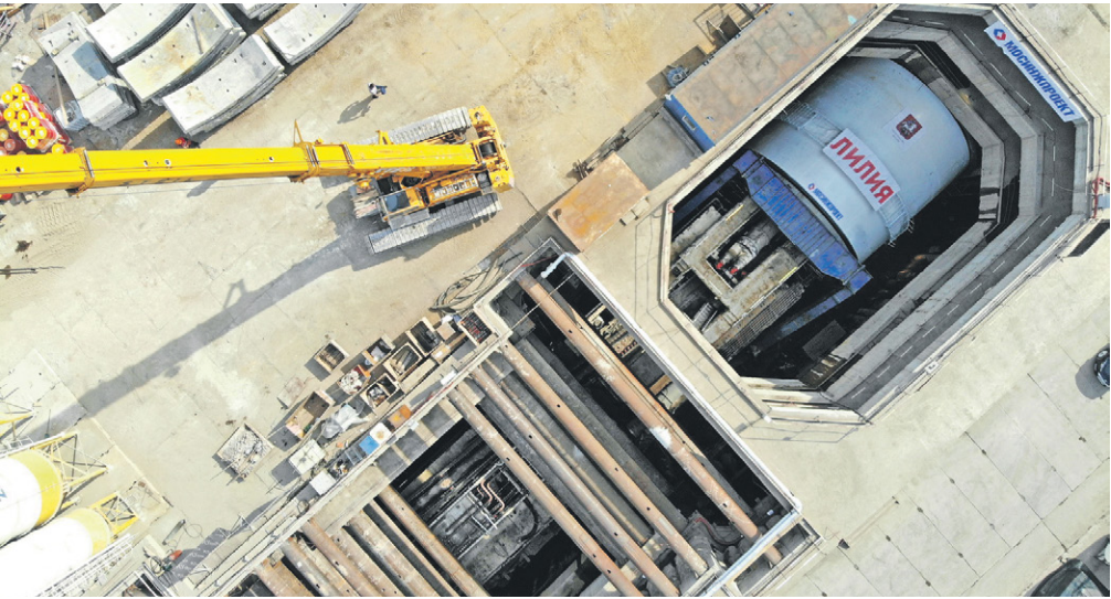
10-метровый щит «Лилия» строит перегон на западе БКЛ
