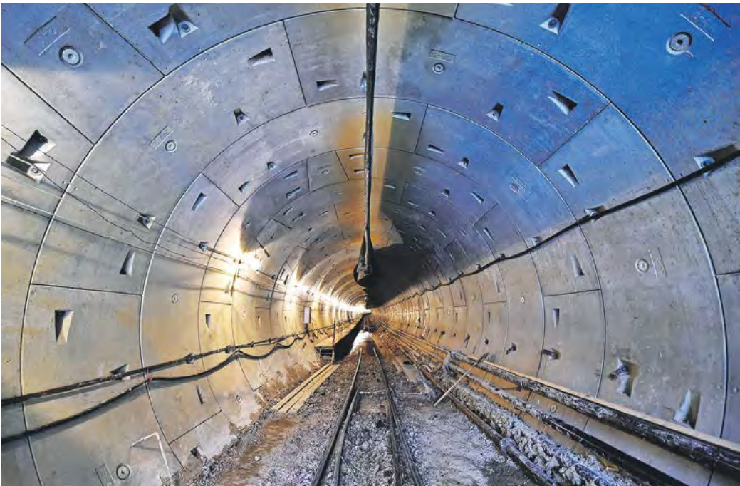
На БКЛ одновременно строятся 18 тоннелей
