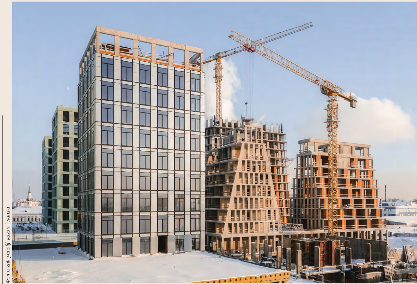
Ход строительства ЖК «Яналиф», Казань
