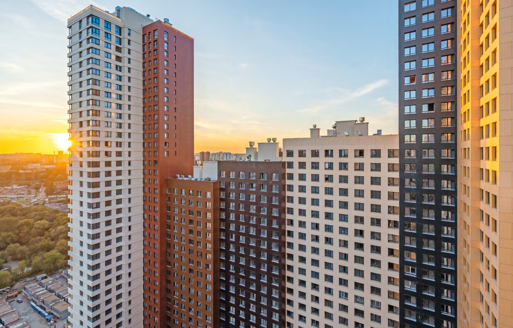
В районе Покровское-Стрешнево завершилось возведение первого и самого большого корпуса жилого комплекса Sky Garden на северо-западе Москвы
