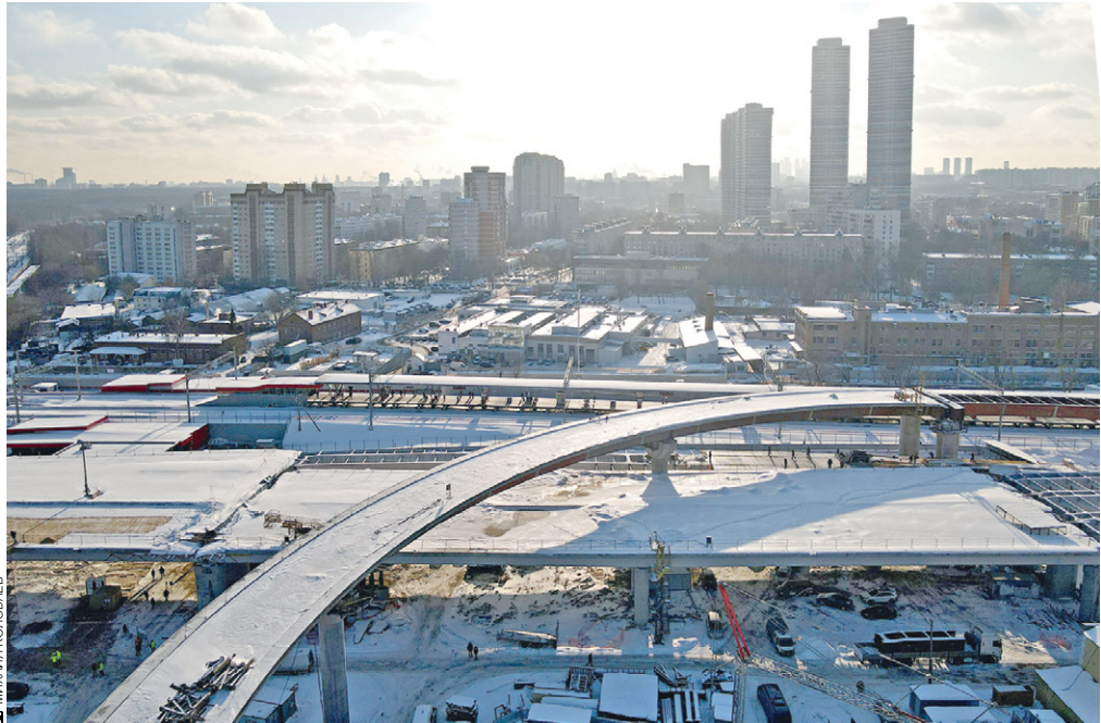
Строительство развязки на пересечении проспекта Мира, переходящего в Ярославское шоссе, и Северо-восточной хорды в завершающей стадии
