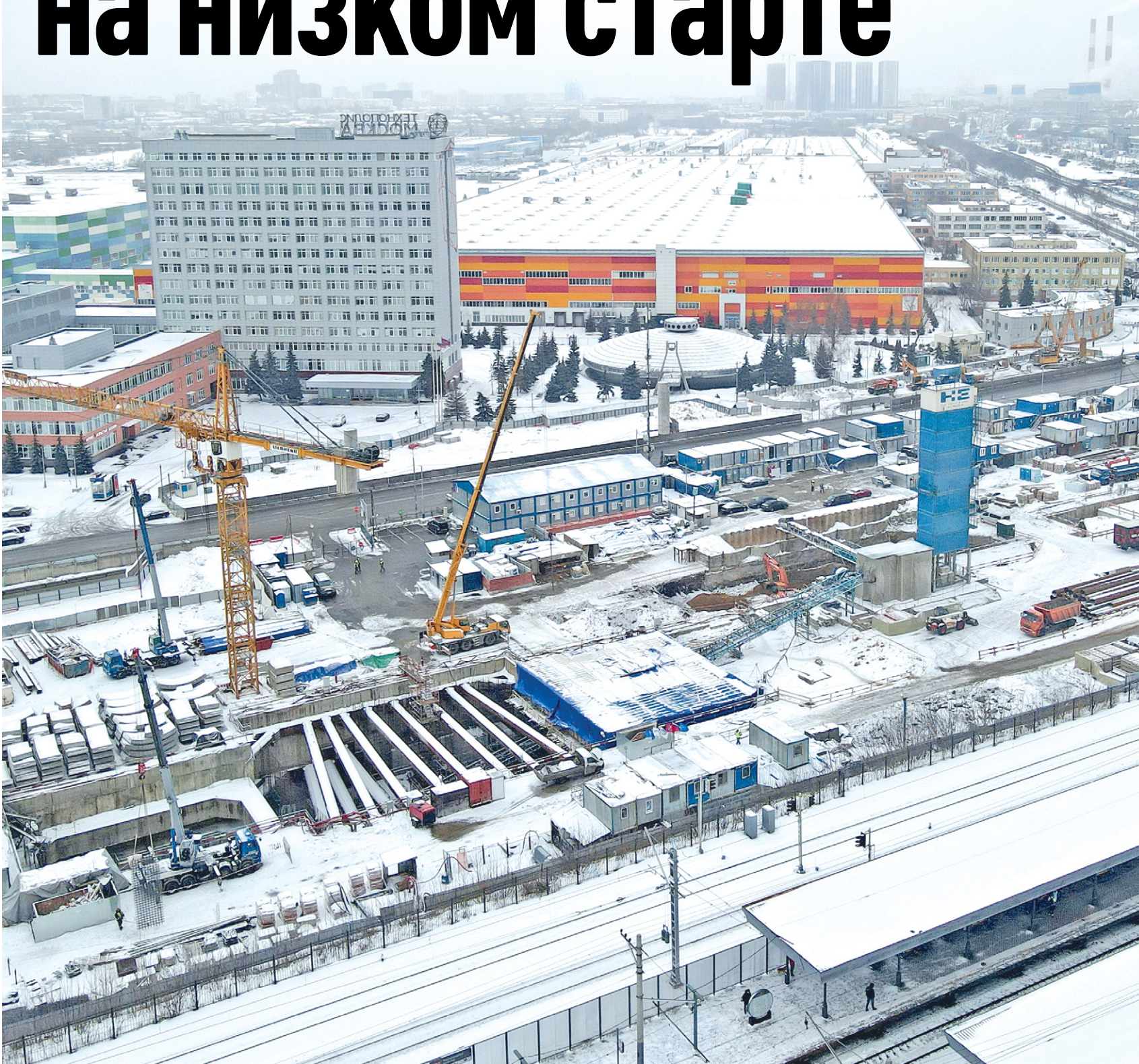
На базе станции «Текстильщики» появится транспортно-пересадочный узел, который объединит потоки пассажиров Таганско-Краснопресненской и Большой кольцевой линий метро, а также радиального направления железной дороги и МЦД-2 «Нахабино – Подольск»
