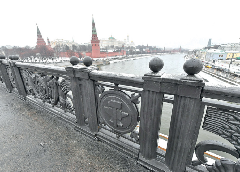
Новый тротуар с отстреливаемым чугунным ограждением на Большом Каменном мосту
