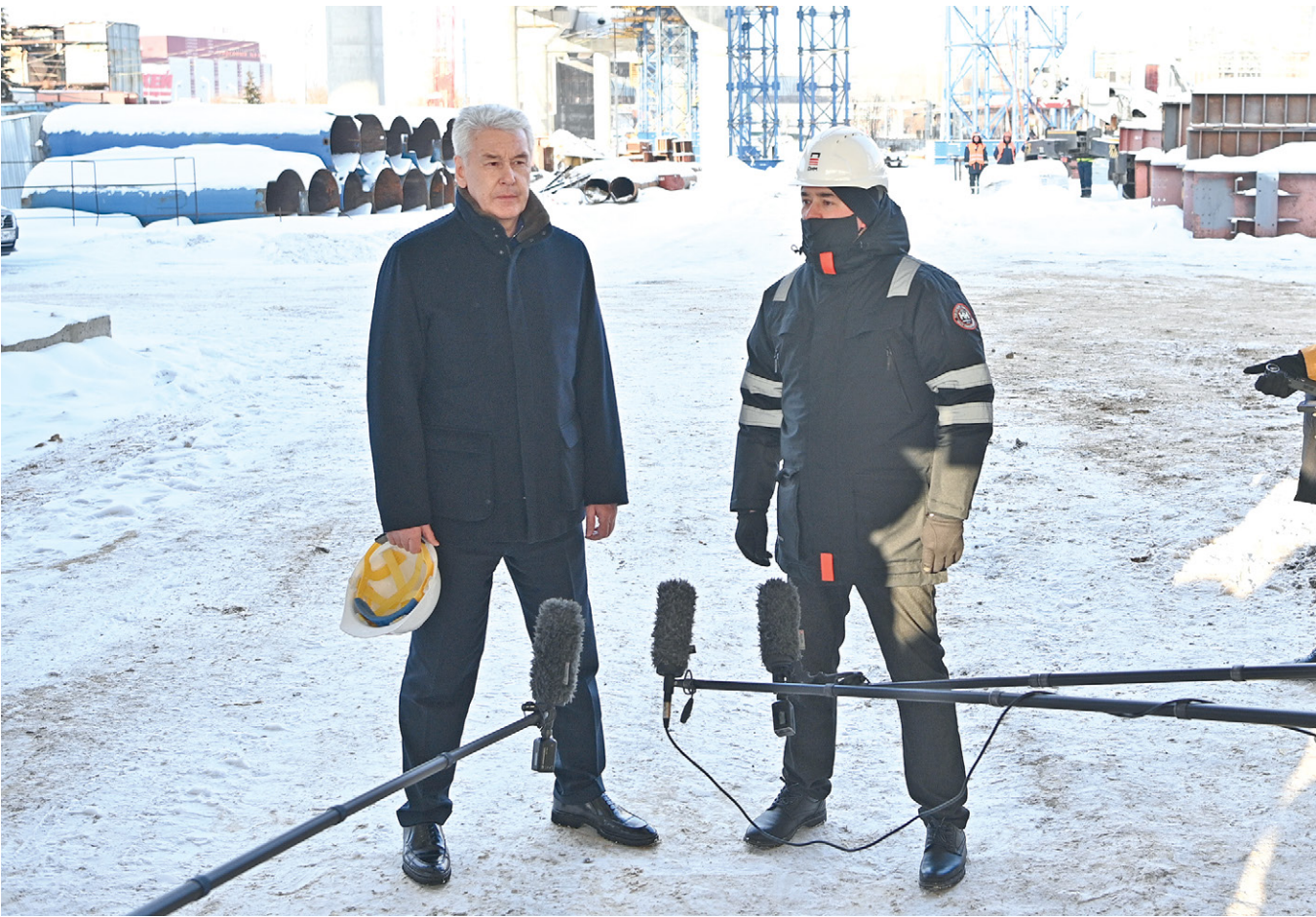
Мэр Москвы Сергей Собянин и представитель компании-подрядчика «Дороги и мосты» Валерий Фабер осматривают ход строительства транспортной развязки на пересечении Северо-восточной хорды и проспекта Мира
