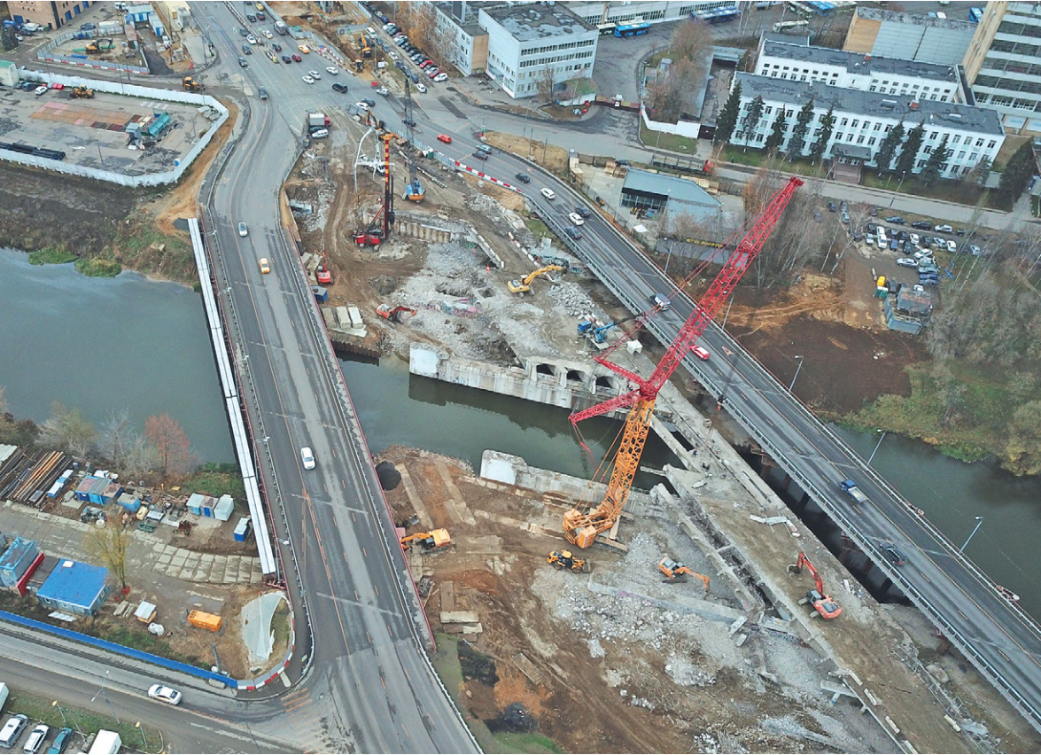
Вид с квадрокоптера на ход работ по реконструкции моста на Волоколамском шоссе через реку Сходню
