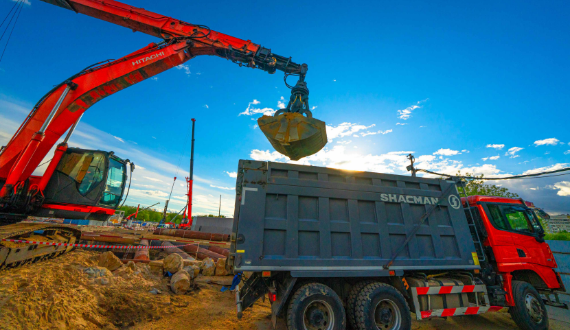
Вывоз строительных отходов для последующей переработки
