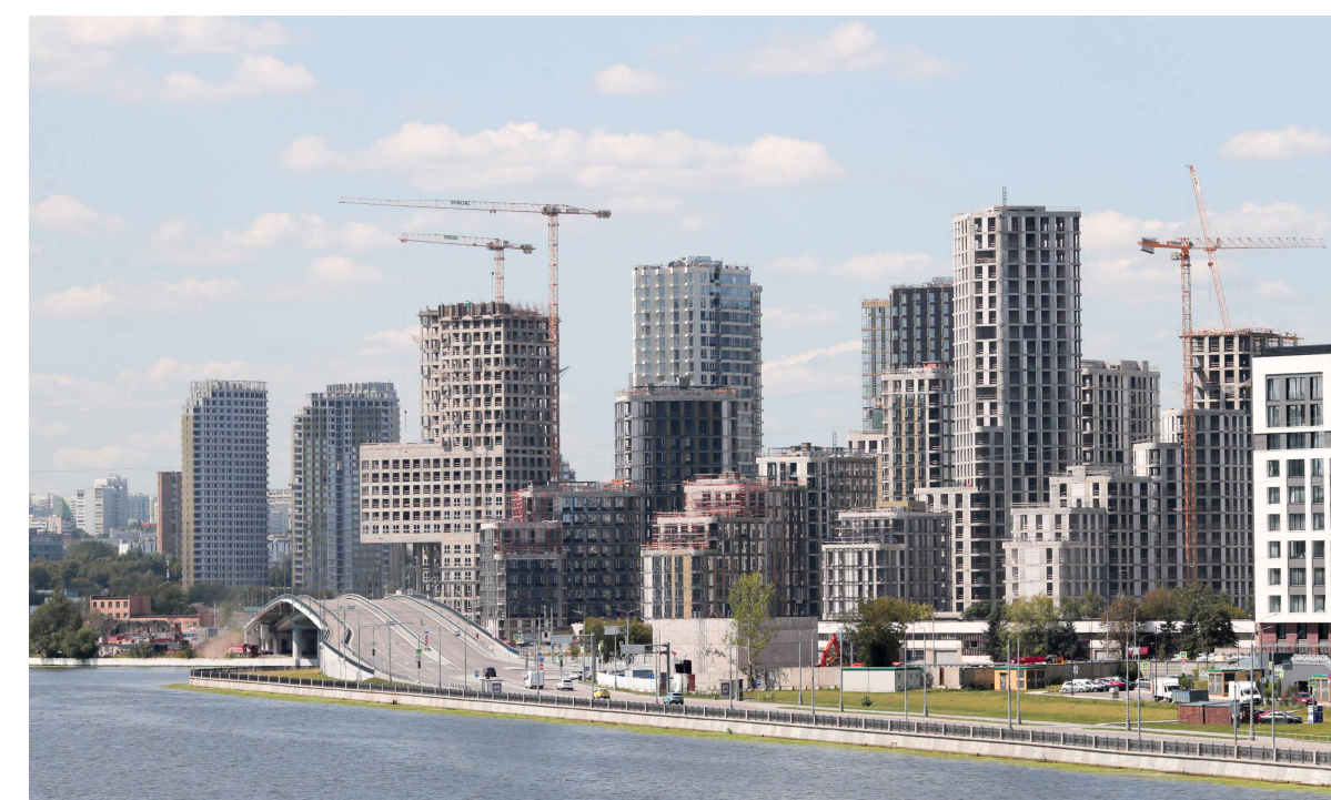
Строительство многофункционального жилого комплекса на ул. Автозаводской
