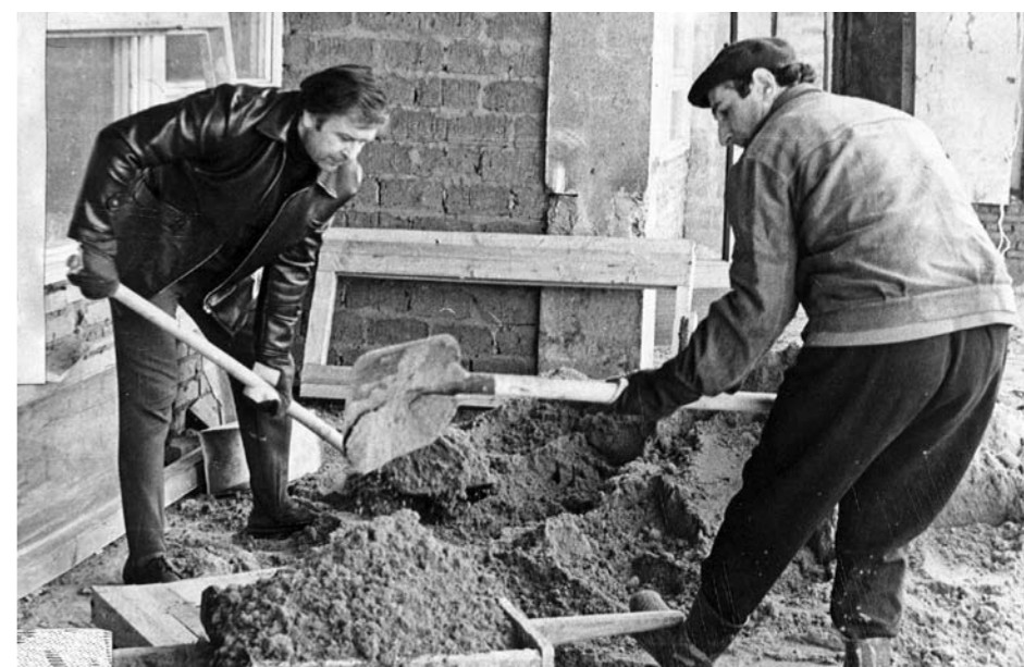
Олег Кирюшин (слева) и начальник ОТК Лев Бахрах. Субботник на строительстве объекта в зоне отдыха МПСМ «Зеленый городок»
