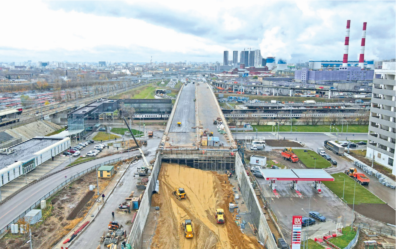
Строительство Юго-восточной хорды от ТТК до Рязанского проспекта
