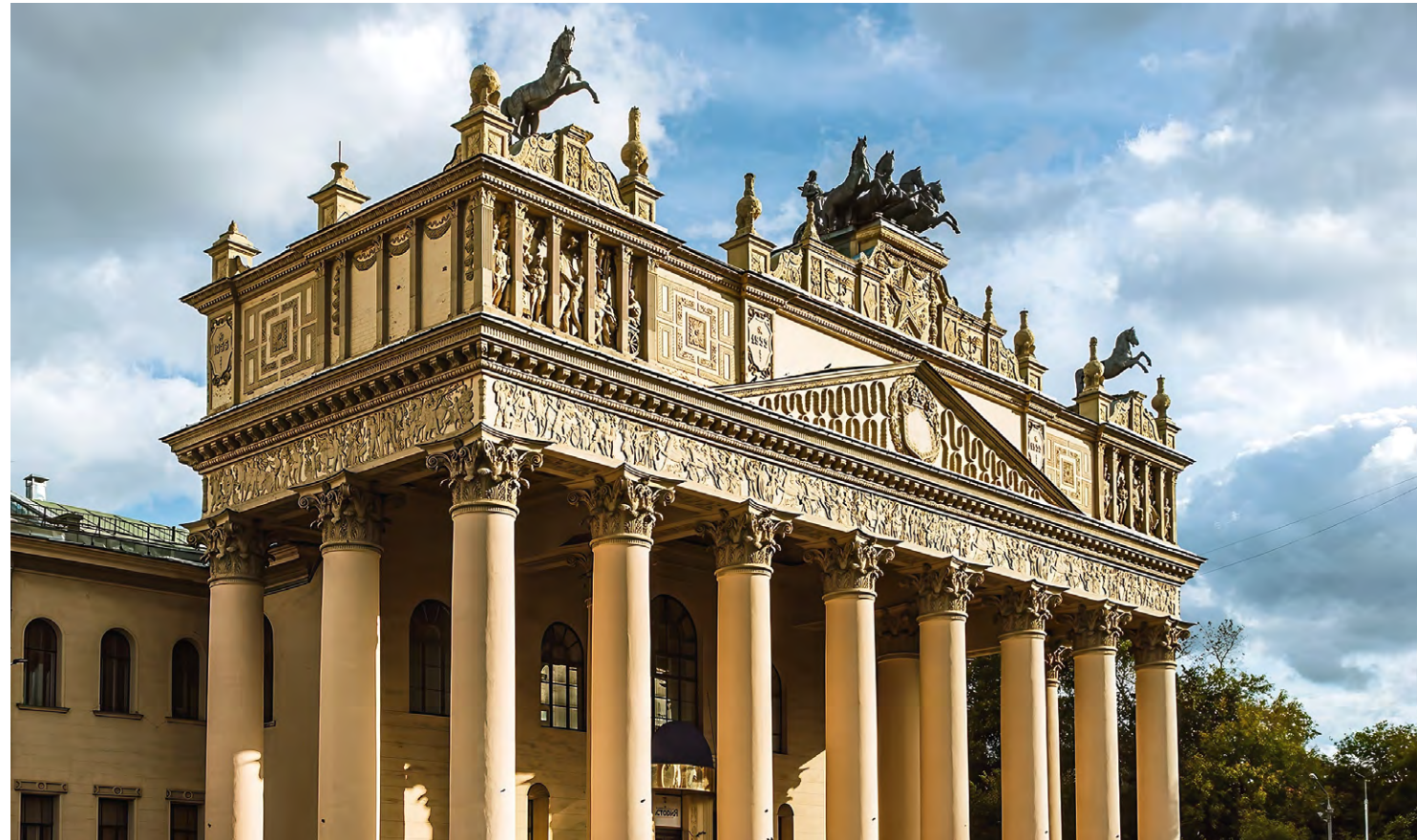
Ход реконструкции Центрального Московского ипподрома в районе Беговой
