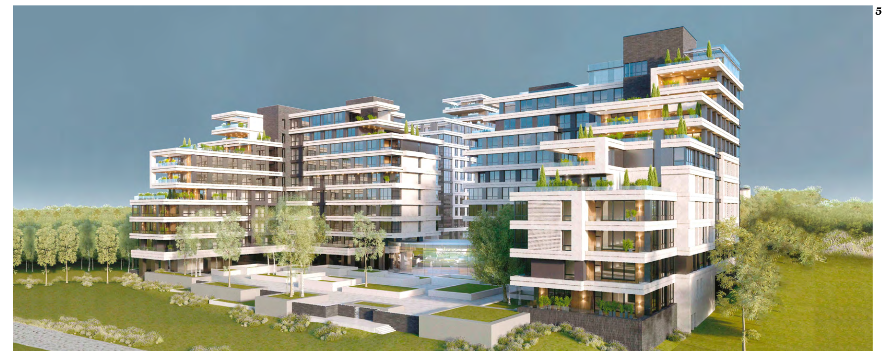
1, 2. Жилой дом «Бакст» в Козихинском переулке. 3. Конкурсе «Новая стрелка», Берсеневская набережная. 4. Многофункциональный комплекс, конкурсе Тишинская площадь. 5. Жилой комплекс «Река», улица Сергея Бондарчука.
