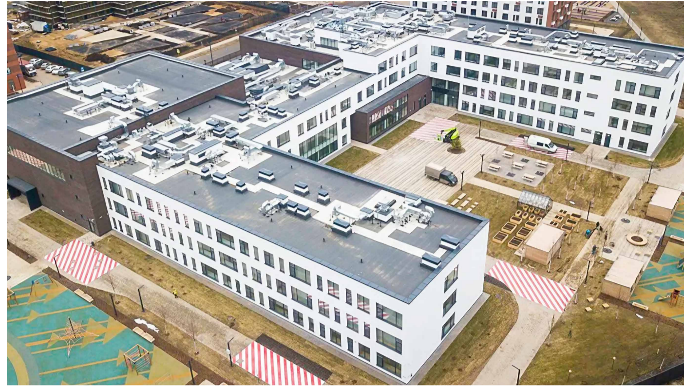
В поселении Сосенское завершено строительство школы на 1150 мест
