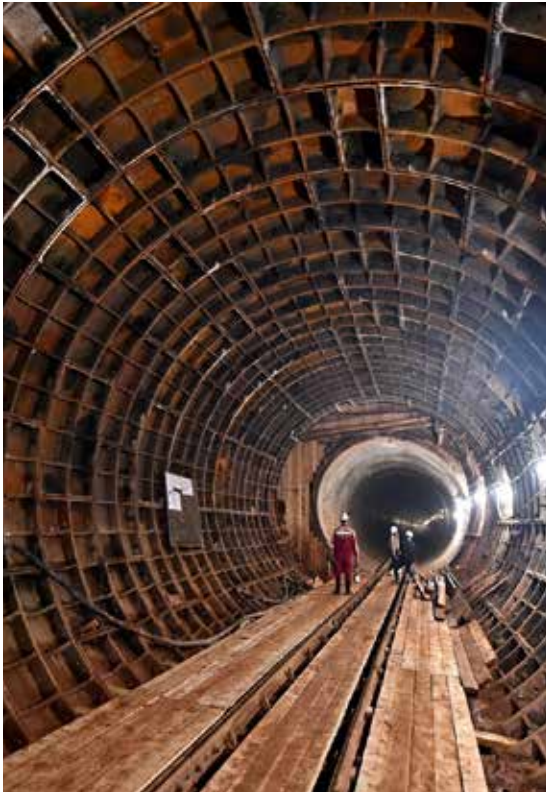
Строительство станции «Рижская» на Большой кольцевой линии
