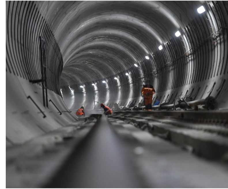
Строительство Троицкой линии метро
