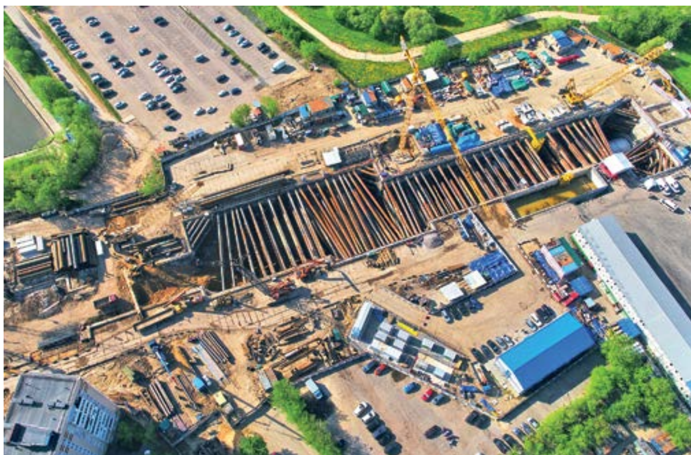
Площадка строительства станции «Кленовый бульвар»
