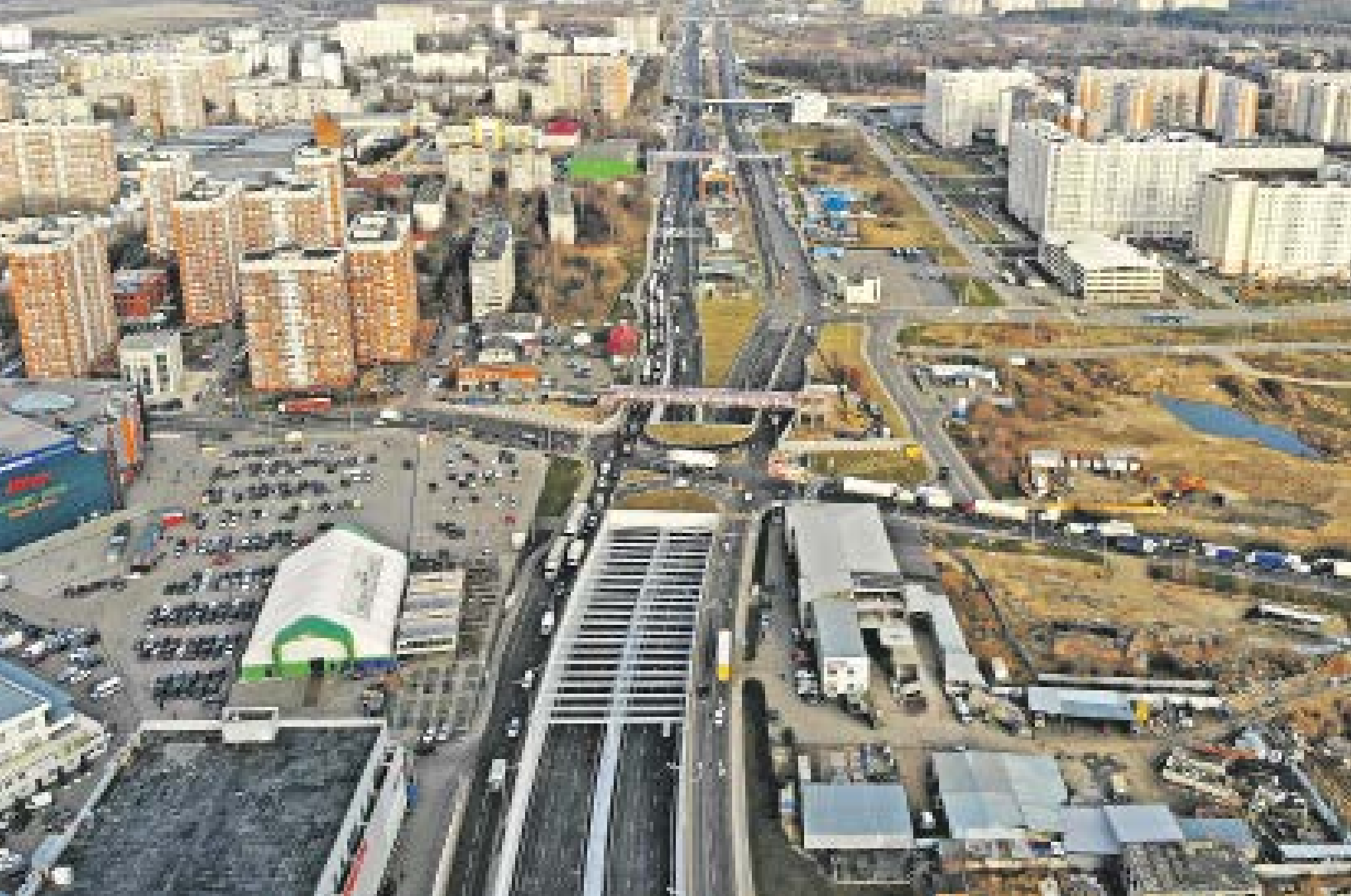
Пропускная способность участка Варшавского шоссе выросла на четверть после реконструкции
