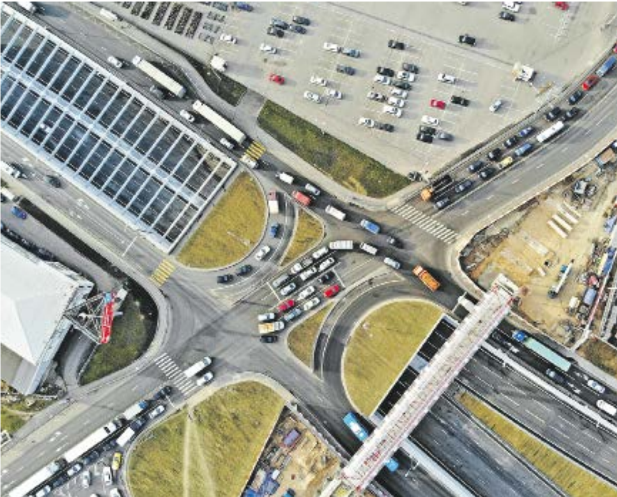
Строительство развязки на Варшавском шоссе завершено с опережением сроков
