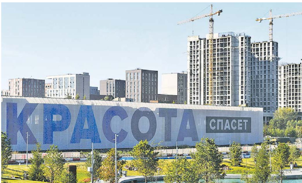
Контроль помогает строить качественно и красиво
