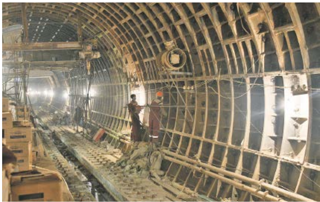
Подземные пути протянулись до станции метро «Савеловская» БКЛ
