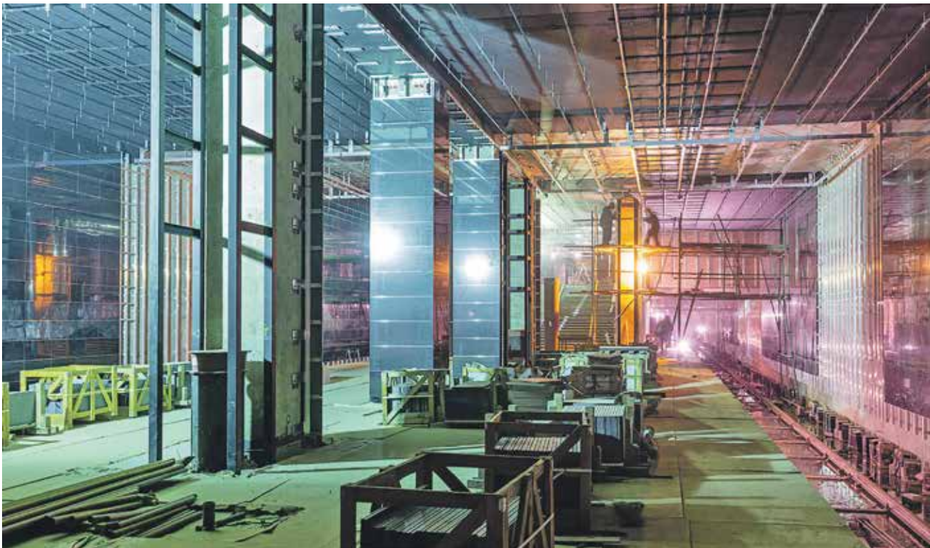
На станции «Лефортово» идут отделочные работы
