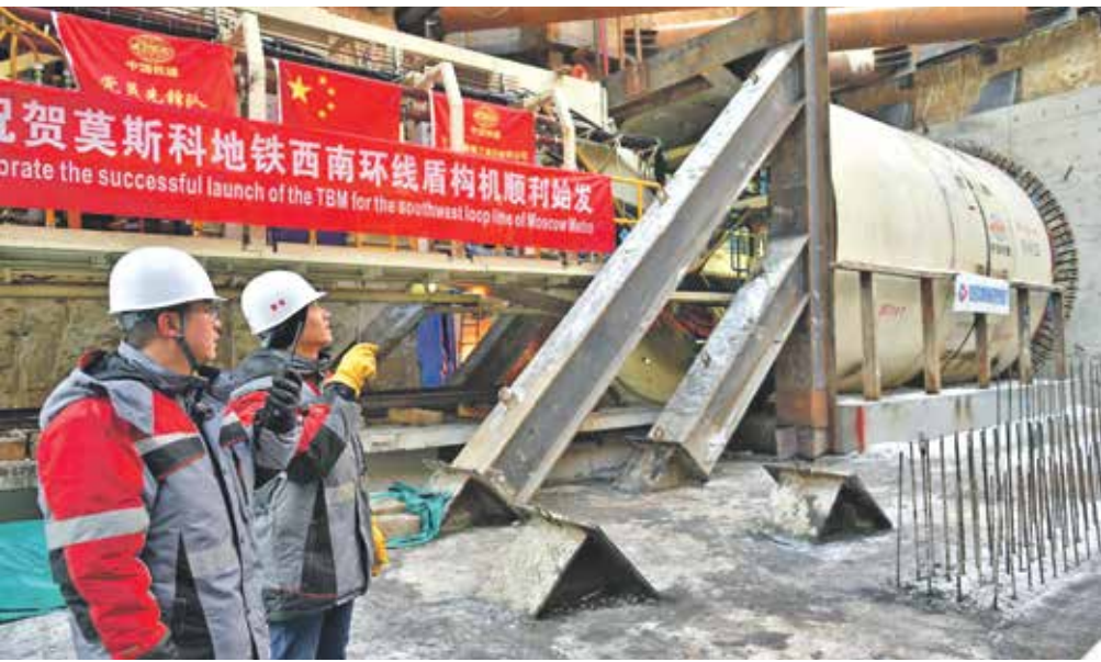
Строительство станций и перегонов на юго-западном участке ведет китайская компания CRCC
