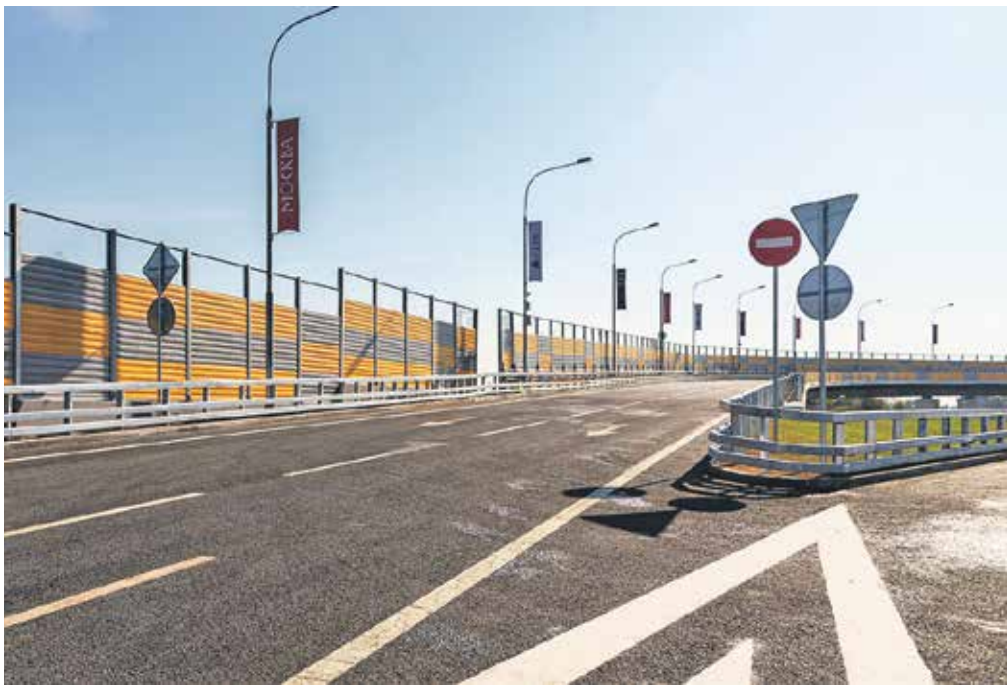
Строительство участка Центральной кольцевой автомобильной дороги (ЦКАД), проходящего по территории Троицкого и Новомосковского административных округов, планируется завершить в 2021 году
