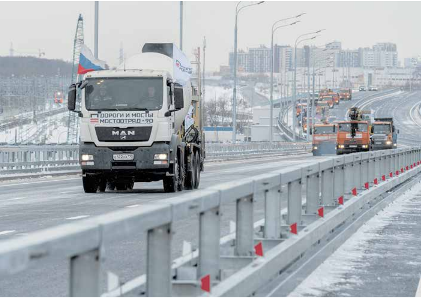
Открытие движения по эстакаде Северо-Восточной хорды от станции МЦК «Ботанический сад» до ул. Сельскохозяйственной
