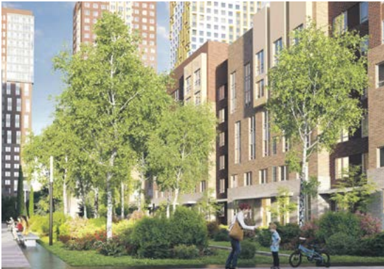
Территория промзоны «Грайвороново» превращается в благоустроенный зеленый район
