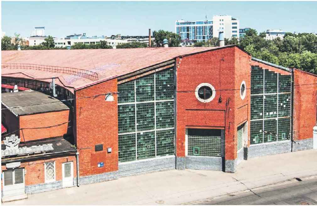
Благодаря полукруглой форме гараж по проекту К. Мельникова смог вместить до 110 крупногабаритных автомобилей
