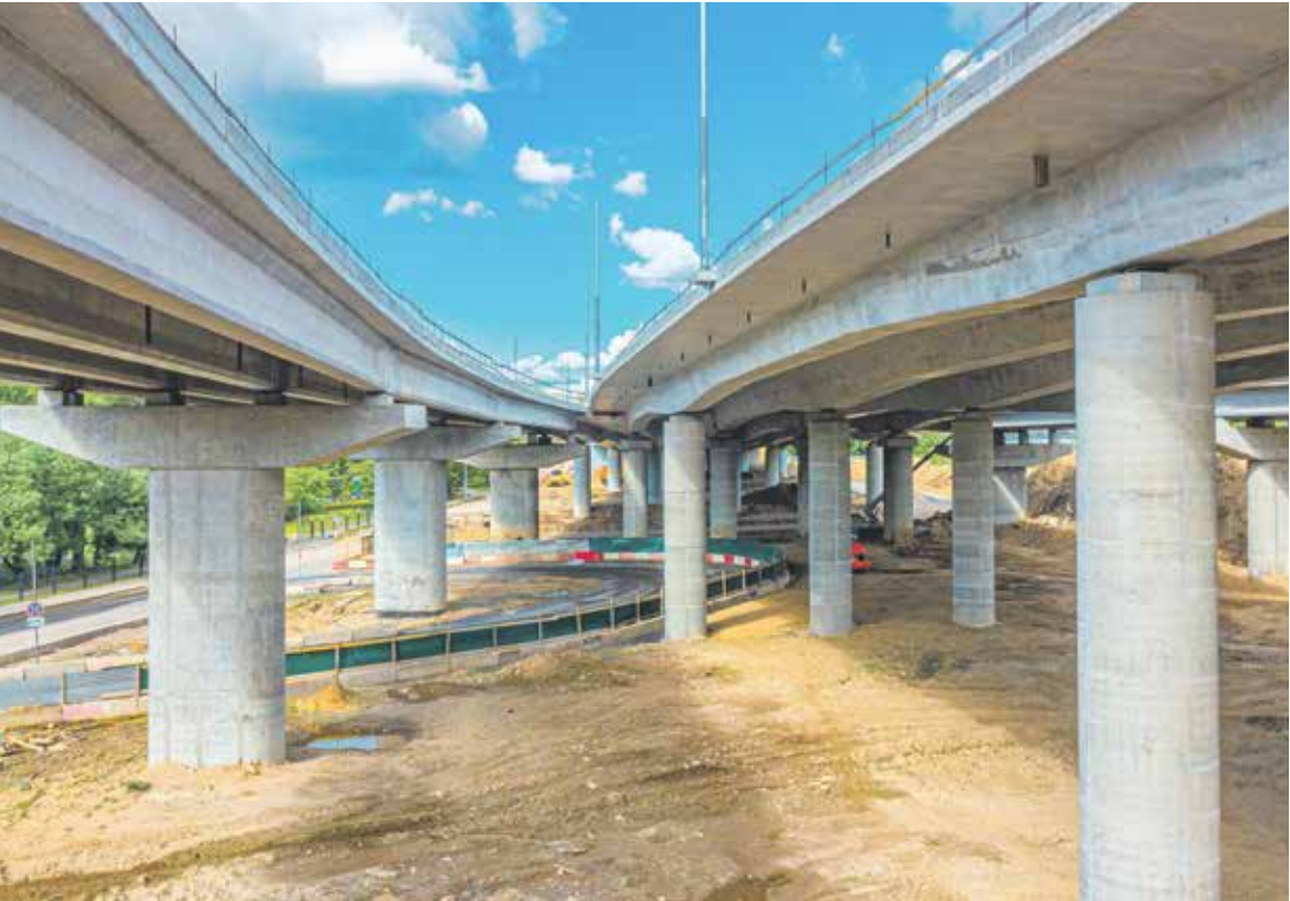
Завершено возведение всех опор эстакады скоростного диаметра на участке от Павелецкого направления МЖД до МКАД
