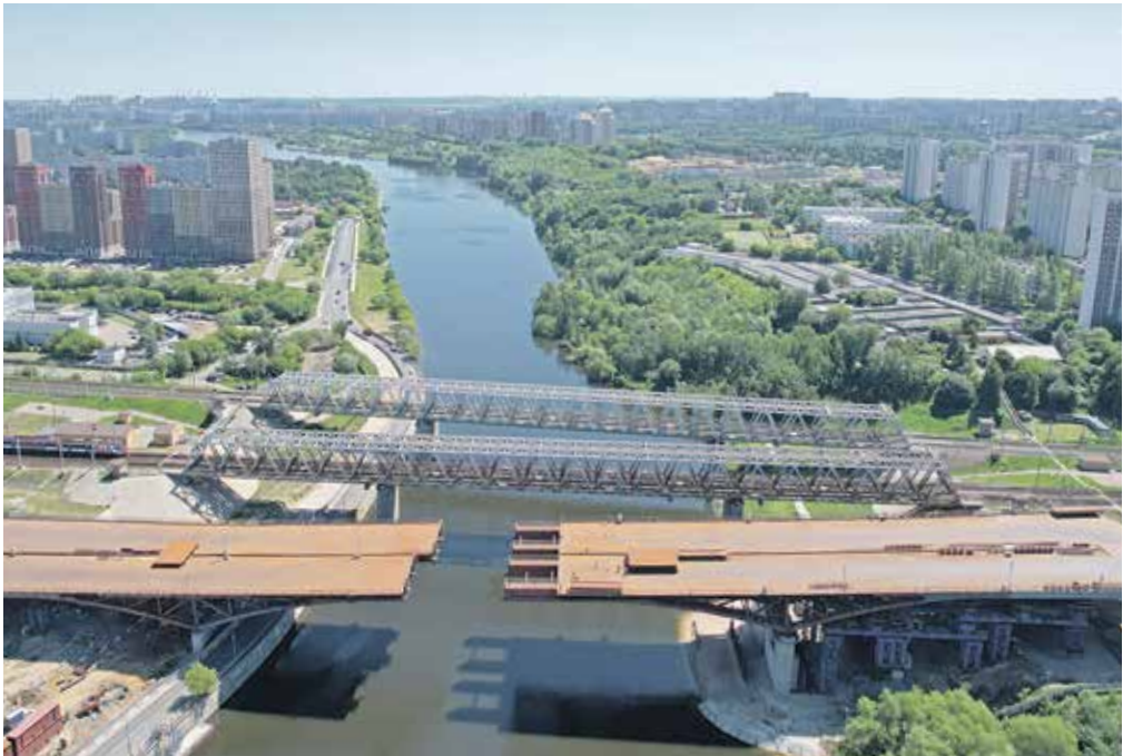
Строительство ЮВХ в районе платформы Замоскворечье
