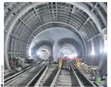
БКЛ строят при помощи щитов диаметром 6 и 10 метров
