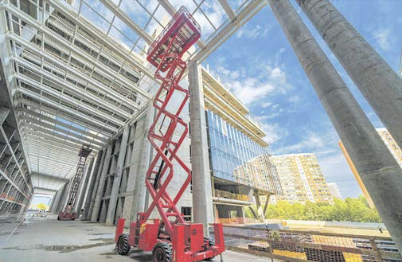
Строительство Национального космического центра
