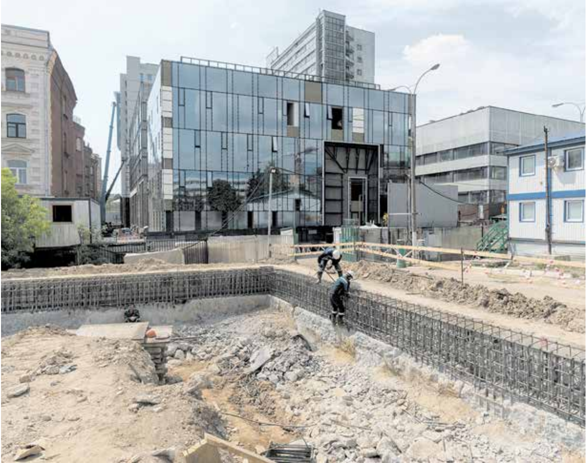
Ход строительства кампуса на территории МГТУ им. Баумана
