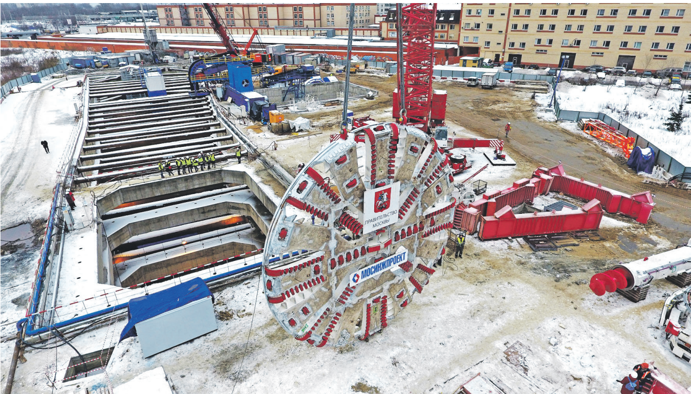
Монтаж 10-метрового ТПМК
