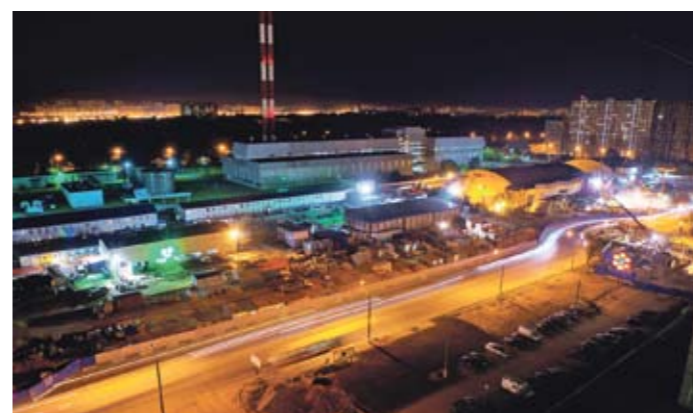
Строительство станции метро «Лермонтовский проспект»
