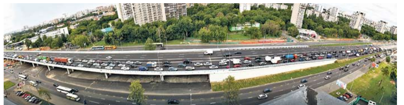
Эстакада на Ярославском шоссе в районе улицы Вешних Вод
