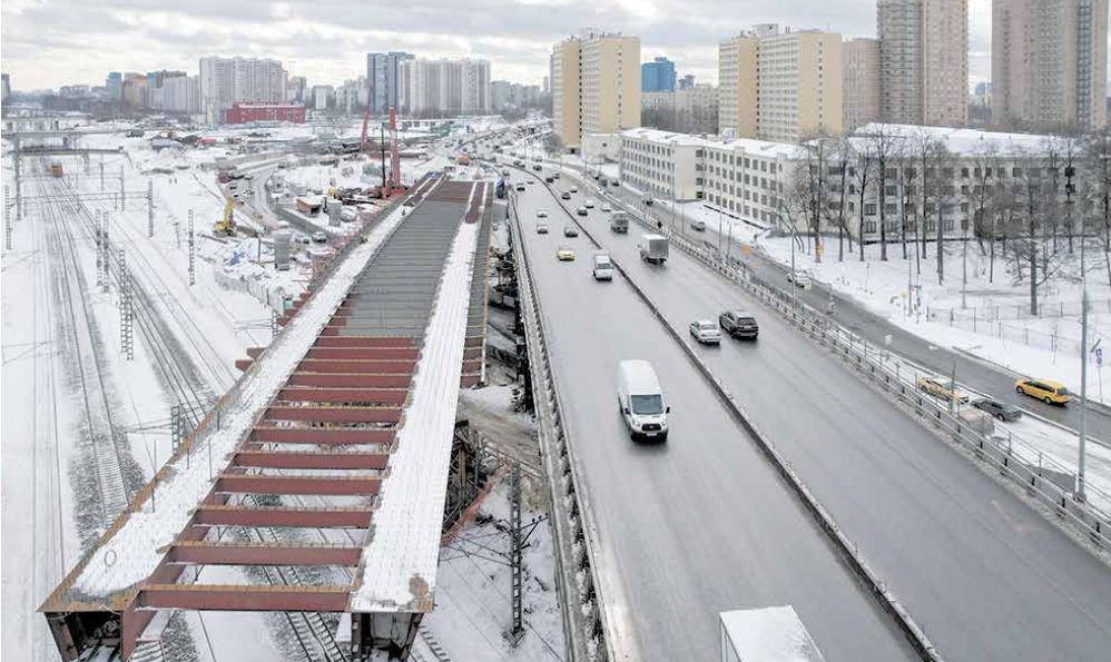
Реконструкция Дмитровского путепровода
