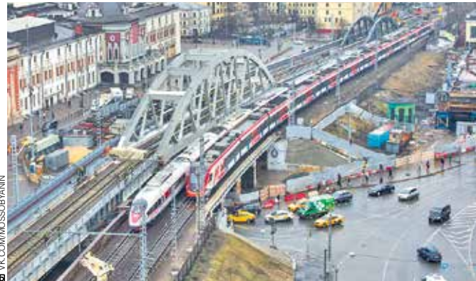
На участке Москва-Каланчёвская – Москва-Пассажирская-Курская предстоит реконструировать главные пути
