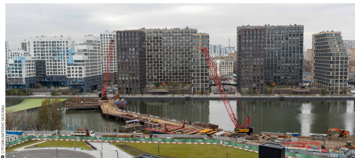
Строительство пешеходного моста через Нагатинский затон
