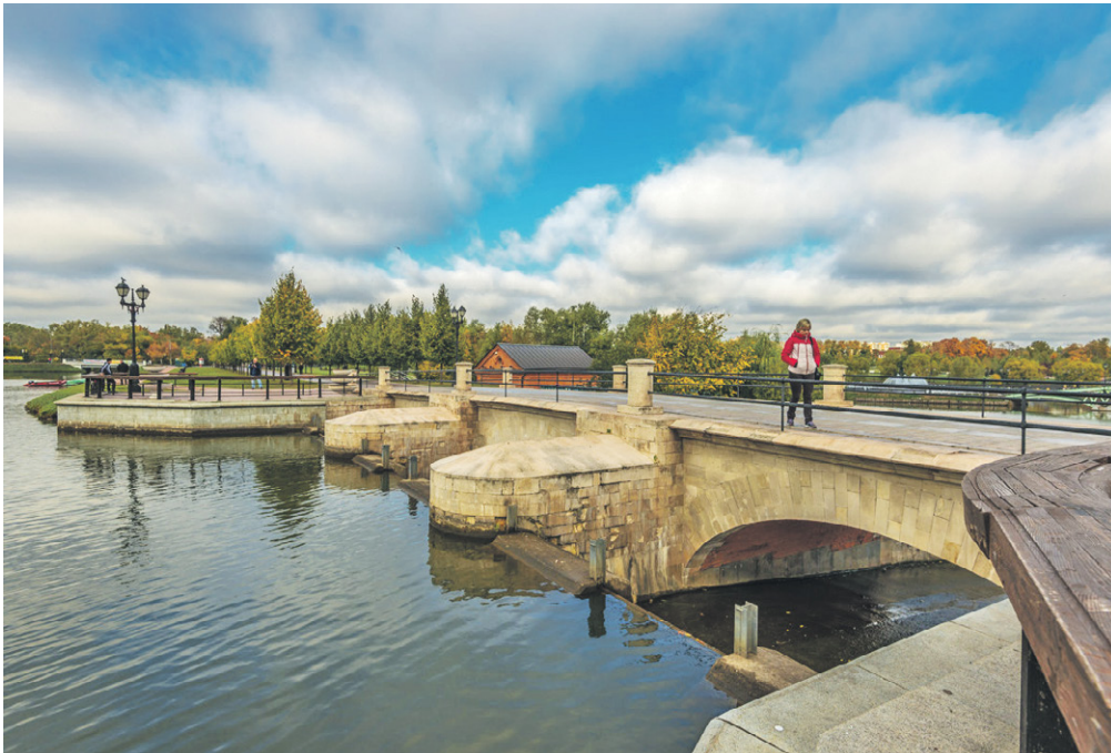
С северной стороны плотина выглядит как трехарочный мост
