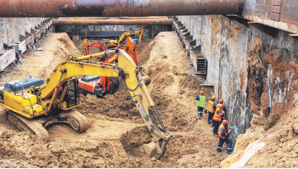
Разработка котлована будущей станции БКЛ «Давыдково»
