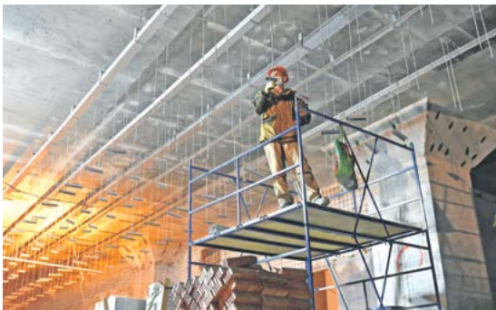
На станции «Нижегородская» начались отделочные работы
