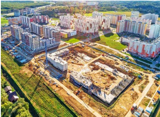
Строительство ЖК «Новые Ватулинки» в ТиНАО
