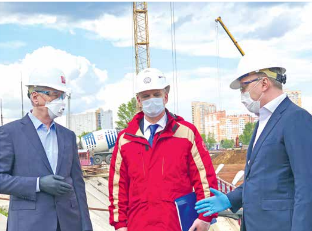
Сергей Собянин (слева), глава стройкомплекса Андрей Бочкарев (справа) и гендиректор «Мосмостростроя» Сергей Жуков на площадке строительства станции метро «Лианозово»
