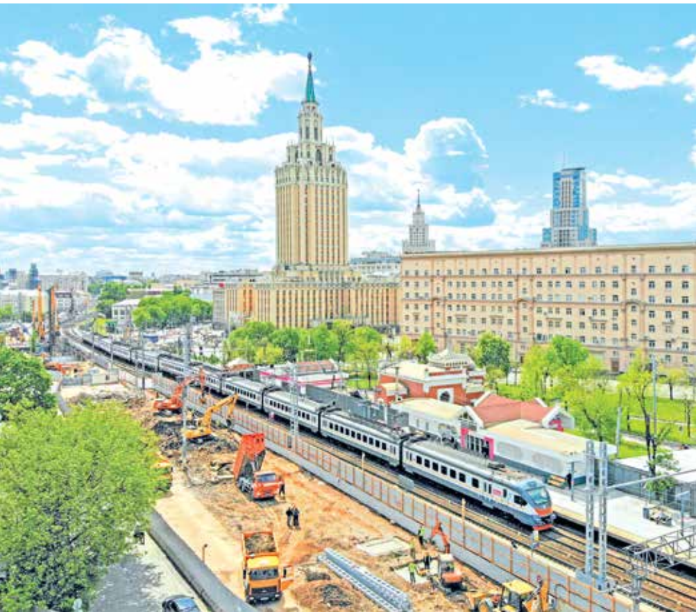
На ж/д станции Каланчевская начали строительные работы
