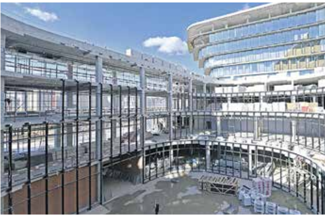
При строительстве были применены уникальные технологии фасадных систем
