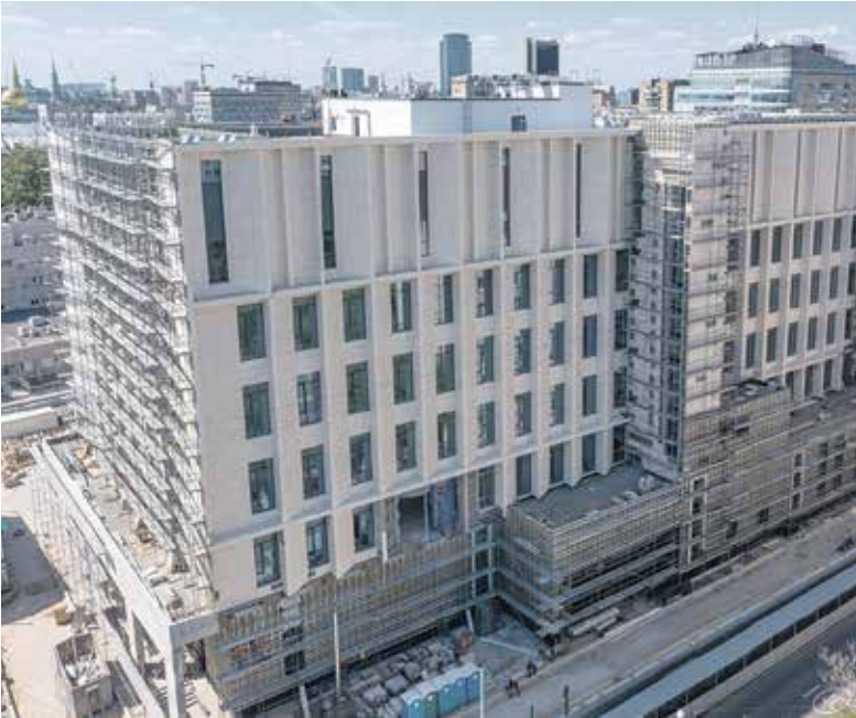
Ход строительства корпуса НИИ скорой помощи им. Н.В. Склифосовского
