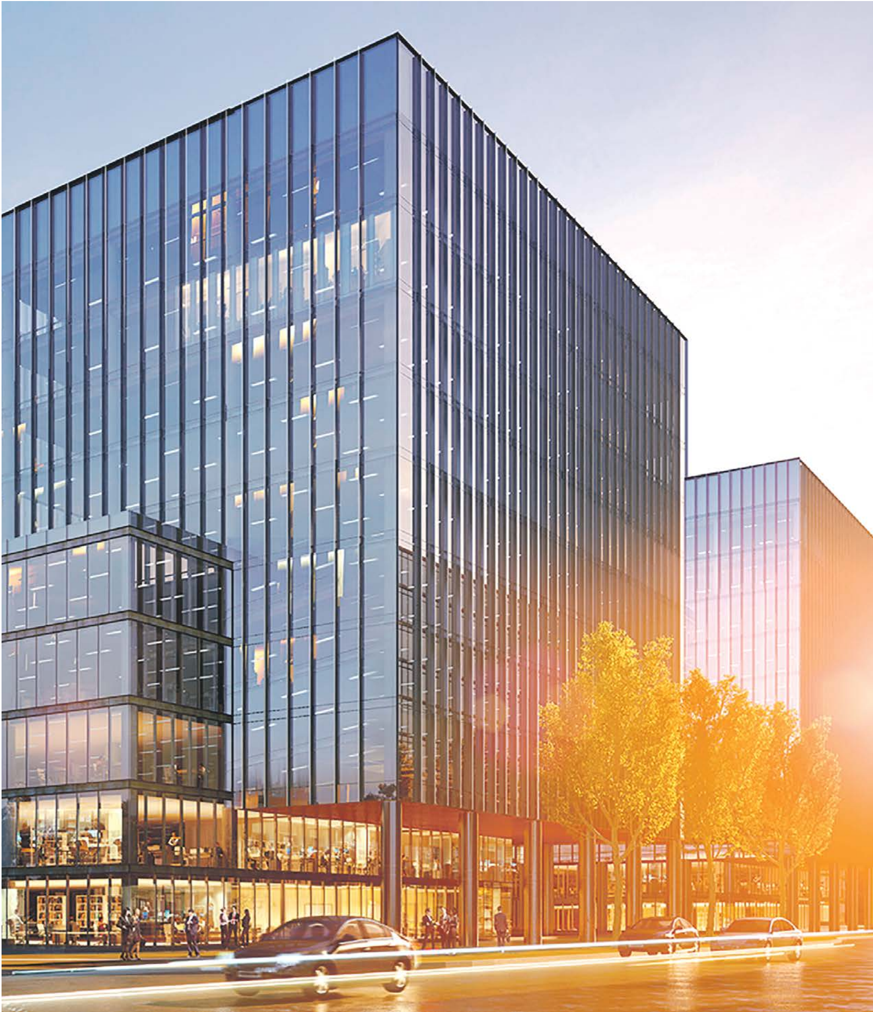
«Ростех-Сити» – крупный офисный комплекс, строящийся на территории Тушинского аэродрома
