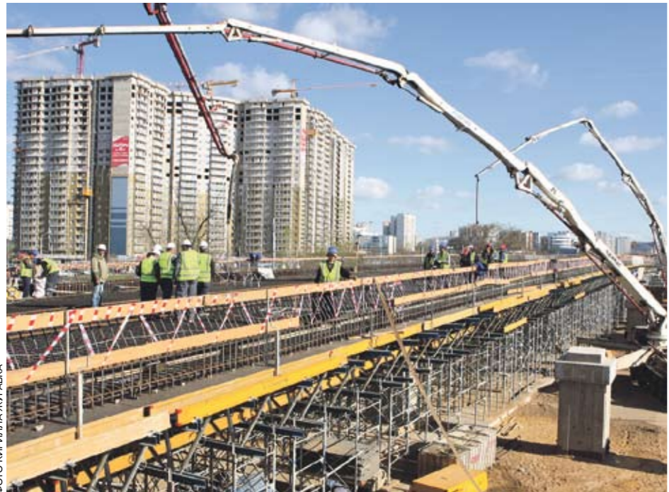
Заливка бетона. Развязка на пересечении Варшавского шоссе и ул. Академика Янгеля
