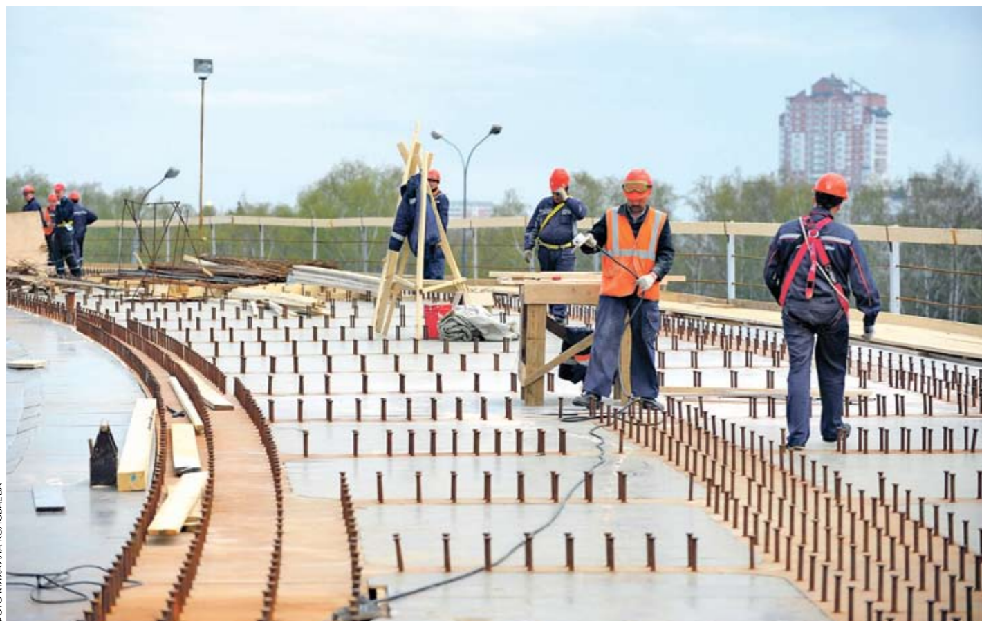
Строители готовят будущий съезд к укладке асфальтового покрытия
