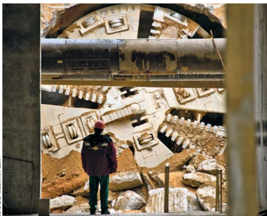
Выход щита на станции метро «Румянцево» Сокольнической линии
