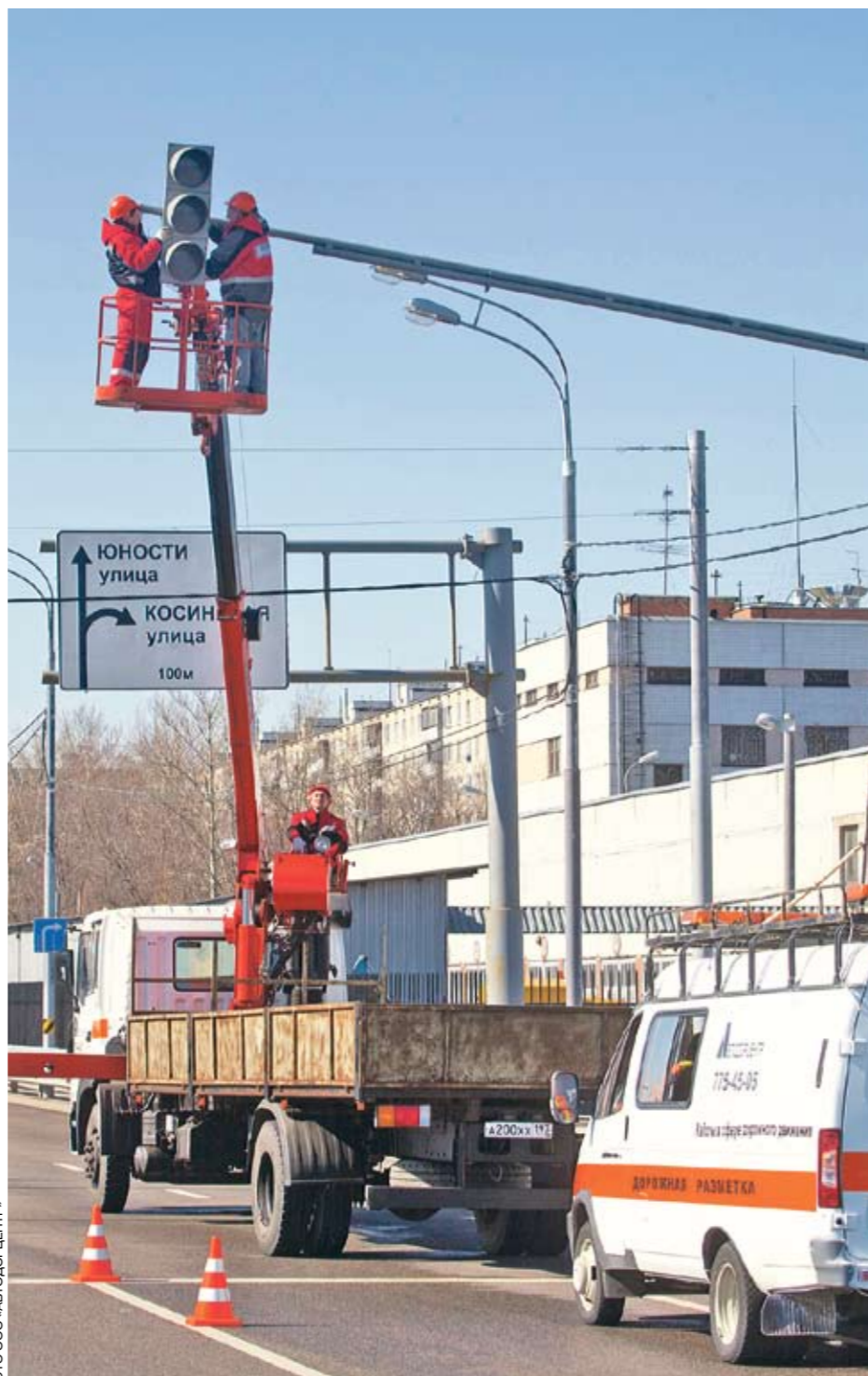
Работы по организации дорожного движения на Рязанском проспекте
