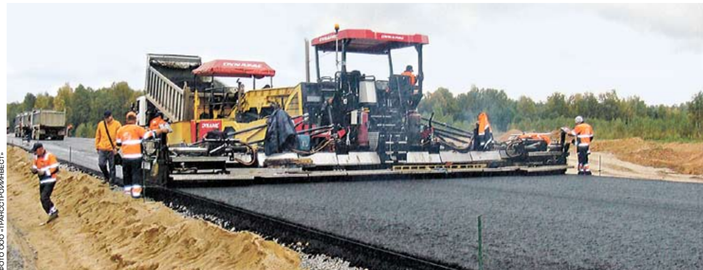
Строительство трассы Москва – Санкт-Петербург в районе Вышнего Волочка
