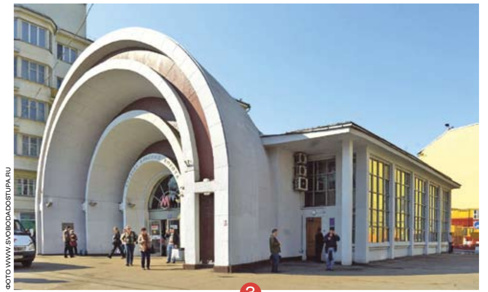
3 Южный павильон станции метро «Красные ворота»
