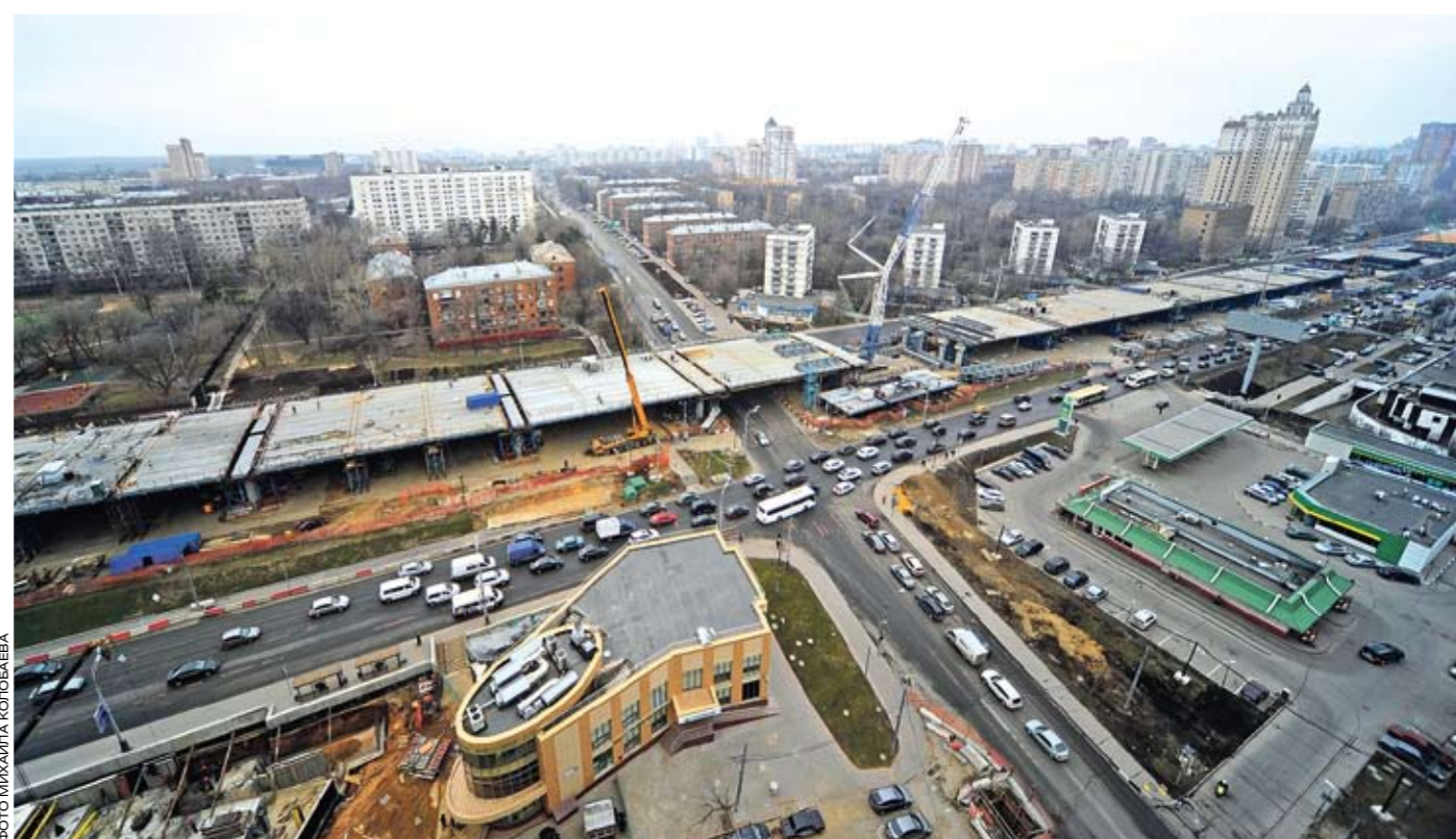
Реконструкция Можайского шоссе
