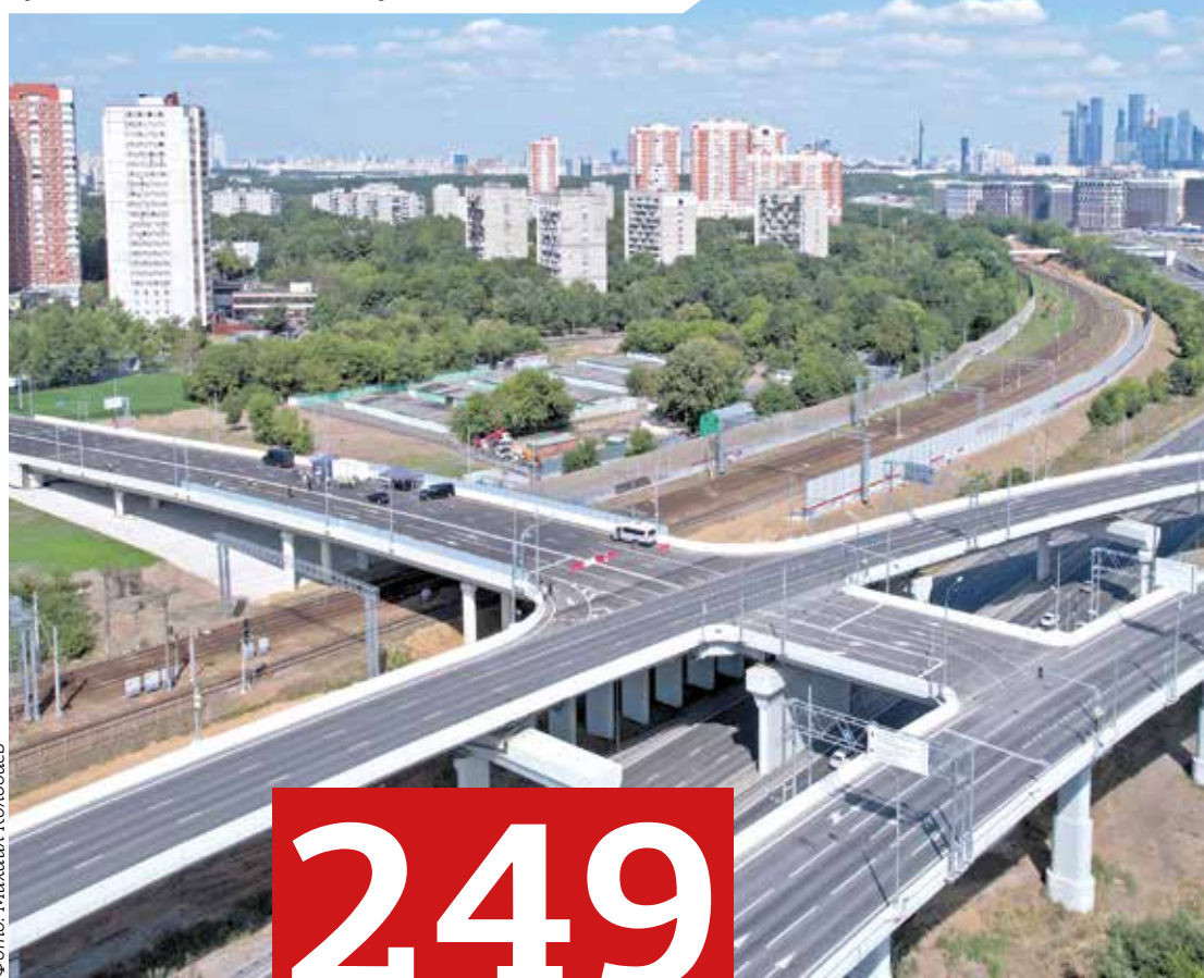
Путепровод на МЦД-4 в районе улицы Генерала Дорохова
