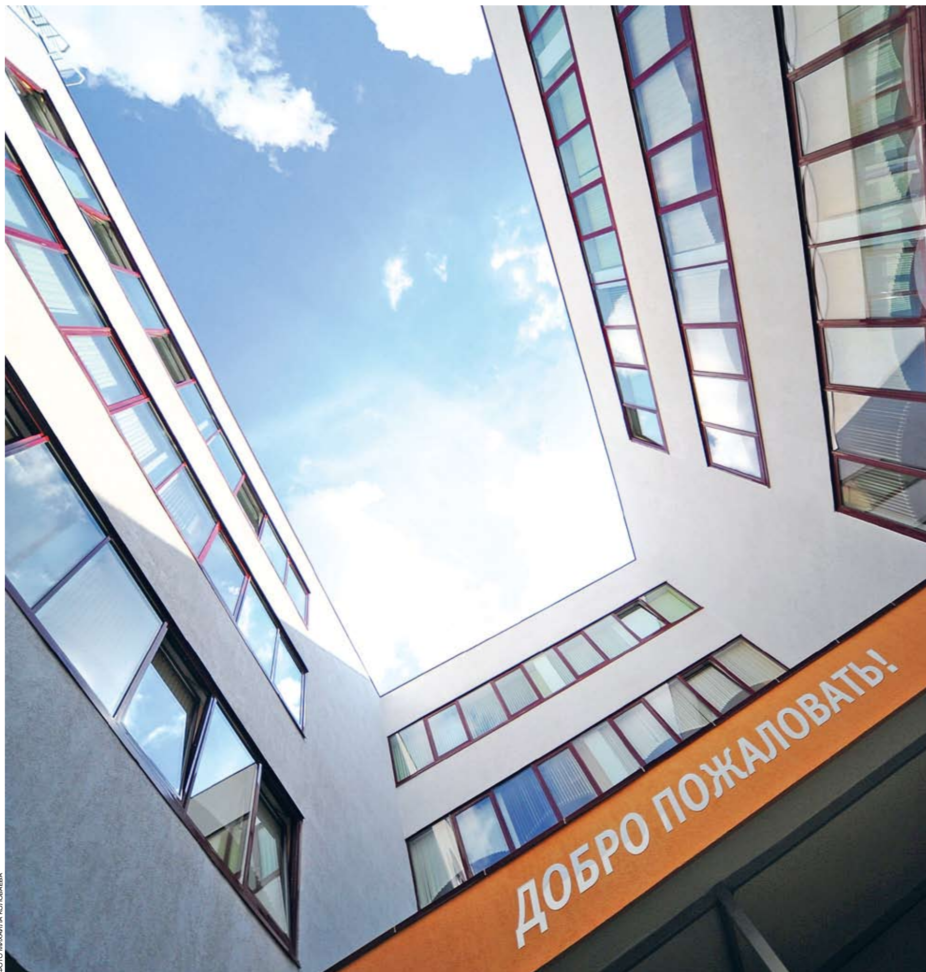
К началу учебного года власти отремонтировали в общей сложности более тысячи школ. (На фото: школа № 446, построенная по экостандартам)
