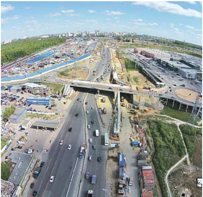
Реконструкция Калужского шоссе
