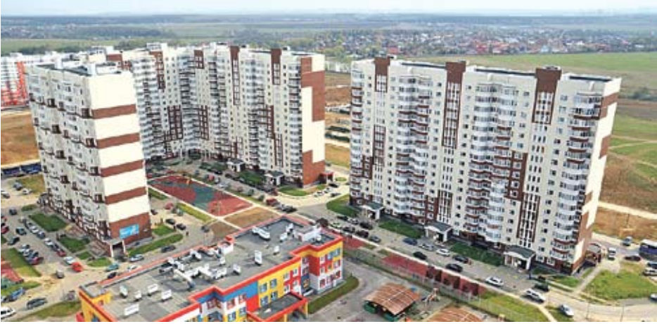
Высокоэтажная застройка. Ватуутинки, мкрн Центральный
