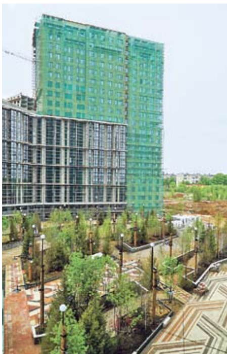
Строительство жилого комплекса «Новая Звезда». Июнь 2016 года
