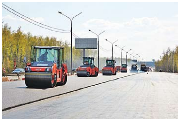
Транспортная развязка подъездной дороги от Москвы к аэропорту «Домодедово»
