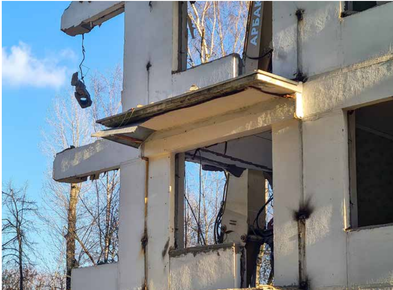
Снос двух пятиэтажных домов в районе Царицыно по программе реновации жилфонда
