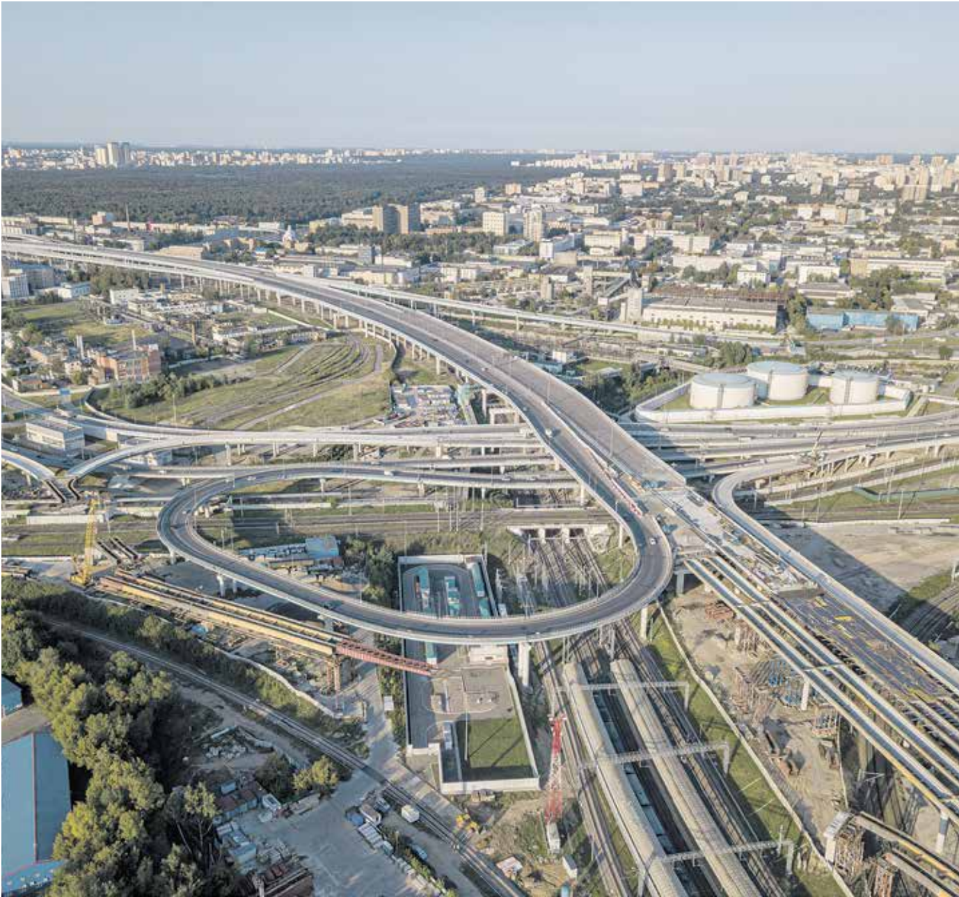
Строительство развязки двух хорд – Юго-Восточной и Северо-Восточной
