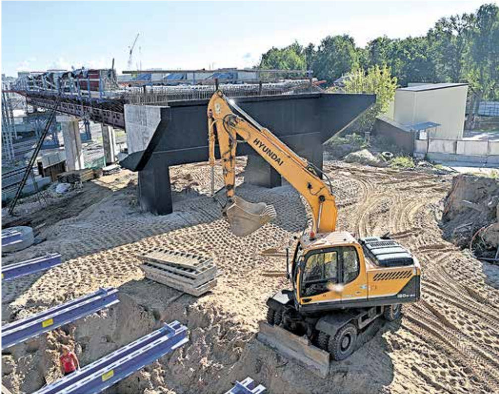
Строительство Северо-Восточной хорды
