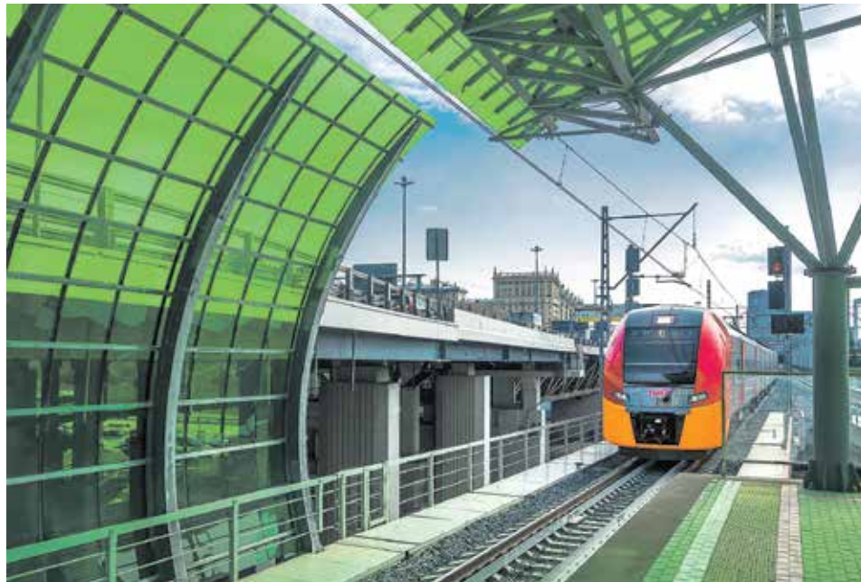
Станция Деловой центр Московского центрального кольца
