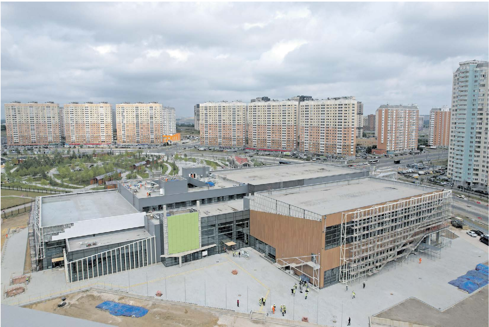
Строительство Дворца спорта «Некрасовка», разработанного по ТИМ-технологиям
